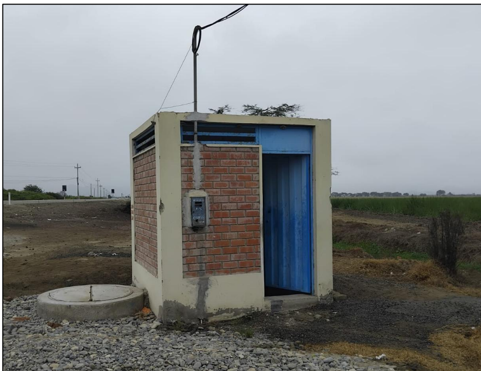
Caseta de bombeo.
