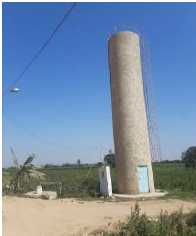
Fotografía 1: Panorámica del árbol de impulsión
