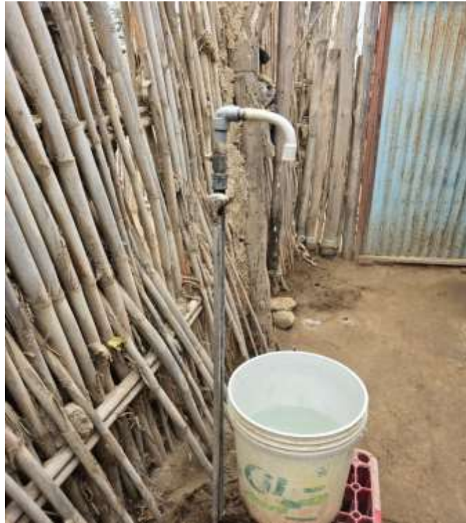
Fotografía 3: Estado actual de las conexiones domiciliarias.
