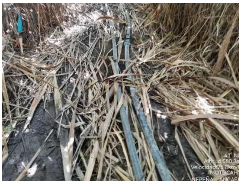
Fotografía 03: Identificación de la línea de conducción, sobre ella tuberías destinadas al regadío.
