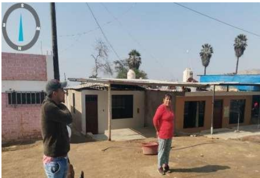
Fotografía 11: Vista general del reservorio.
