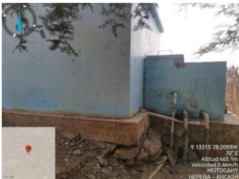
Fotografía 10: Vista general del reservorio.
