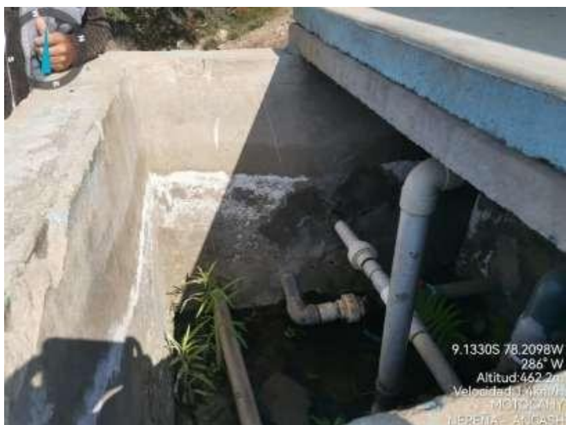
Fotografía 09: Inspección de caseta de válvulas.
