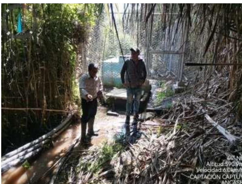
Fotografía 02: Identificación del punto de ubicación de la captación totalmente enterrada.
