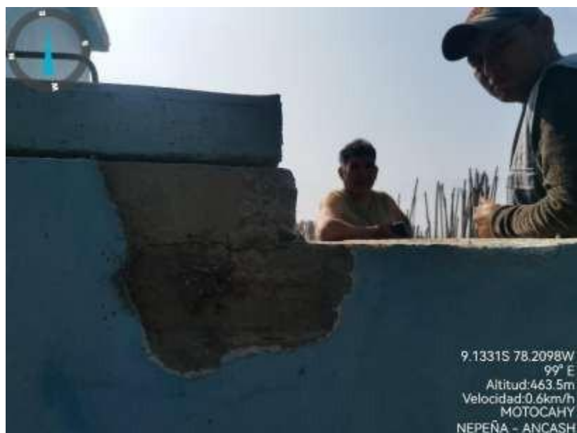
Fotografía 08: Verificado de puntos críticos del reservorio.
