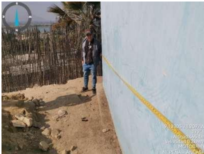
Fotografía 06: Toma de medidas del reservorio.
