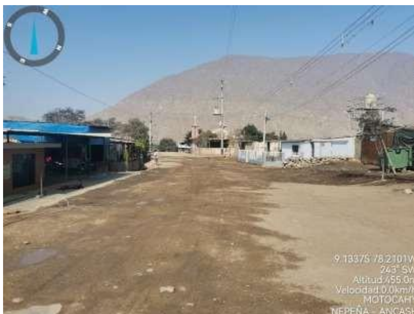
Fotografía 12: Vista panorámica e identificación de recorrido de red de distribución.
