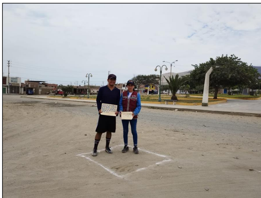
Foto n° 11 Excavación de la calicata C-05 para el estudio de suelos, en l Av. Porvenir.
