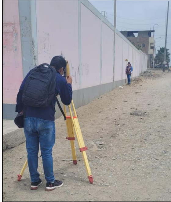
Foto n°01 Levantamiento topográfico en el CP. Cambio Puente en el Pasaje Piura.
