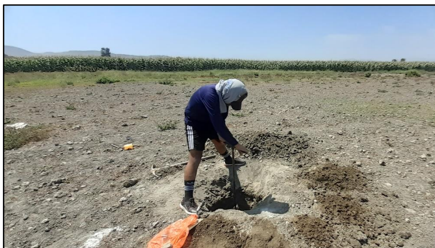
Foto n° 13 Ubicación de la calicata C-06 para el estudio de suelos, en el terreno destinado para la PTAR.
