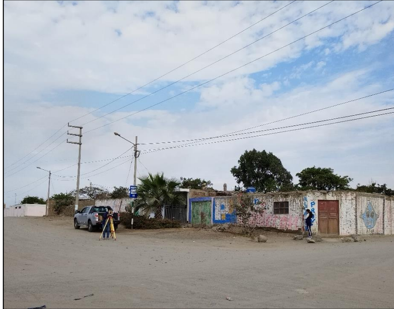
Foto n°03 Levantamiento topográfico en el CP. Cambio Puente en el Jirón San Francisco.
