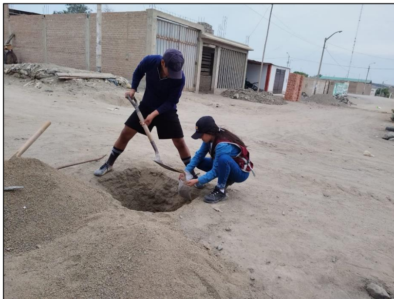
Foto n° 08 Toma de muestra para el estudio de suelos de la calicata C-02, en el Jirón José Gamarra.
