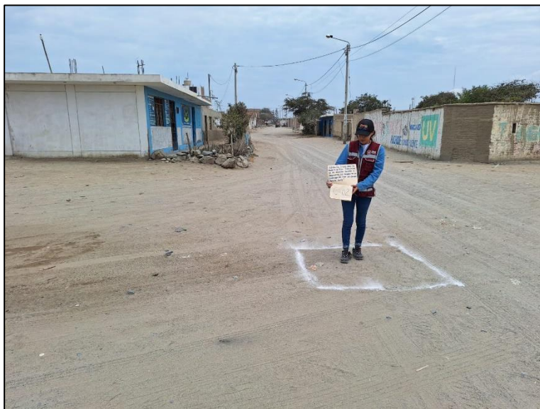
Foto n° 09 Ubicación de la calicata C-03 para el estudio de suelos, en el Jirón Pallasca.
