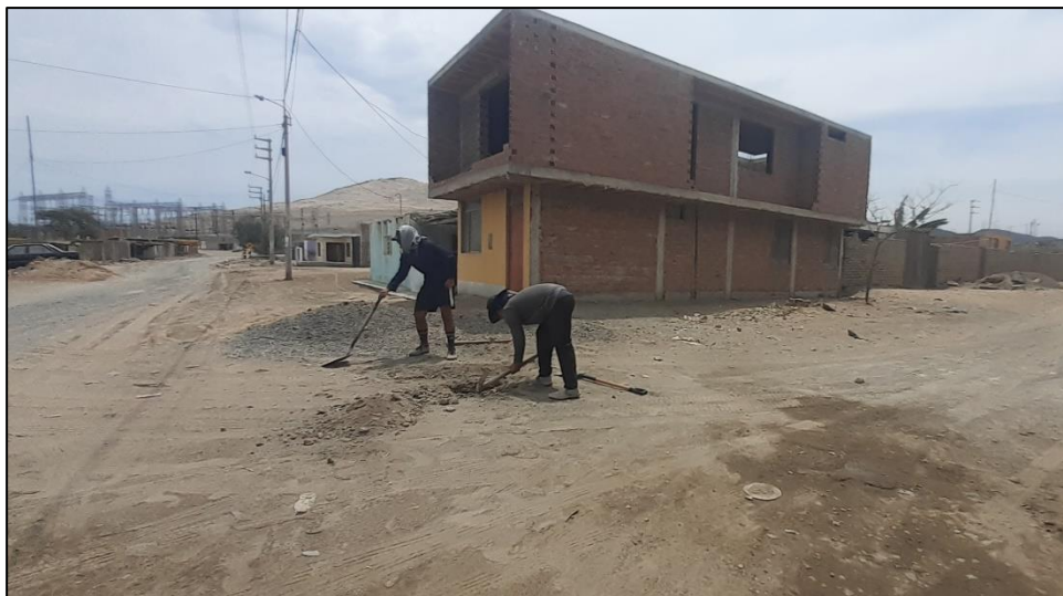
Foto n° 10 Excavación de la calicata C-04 para el estudio de suelos, en l Av. Porvenir.
