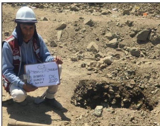
FOTO 03: SE OBSERVA LA EXCAVACIÓN CALICATA C-02.
