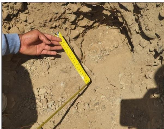
FOTO 05: SE OBSERVA LA EXCAVACIÓN CALICATA C-03.
