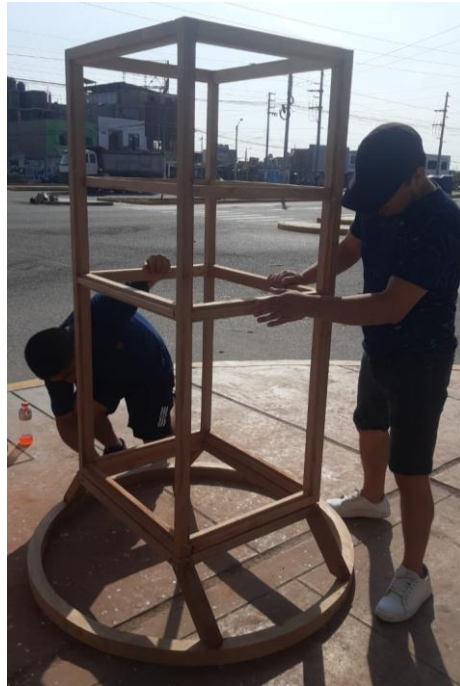
Figura e construcción de la cabina de secado con una bandeja
