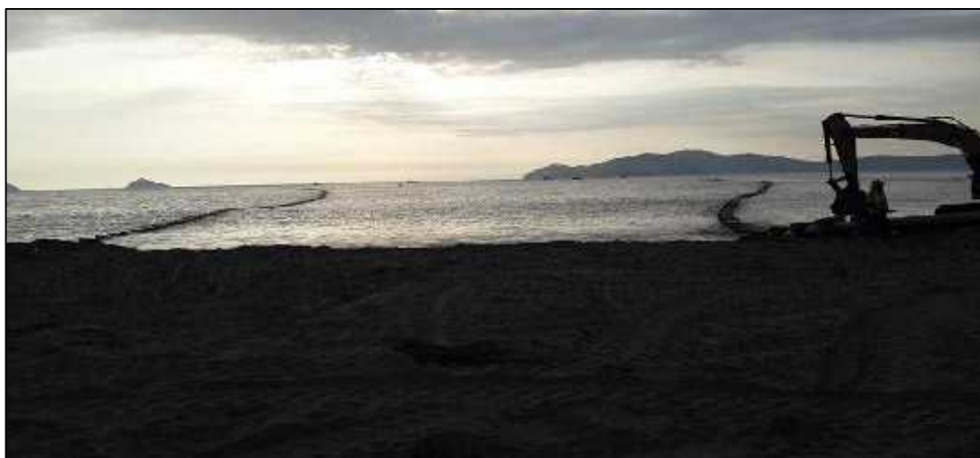
Figura 11: Emisarios submarinos APROFERROL (lanzamiento de tuberías)
