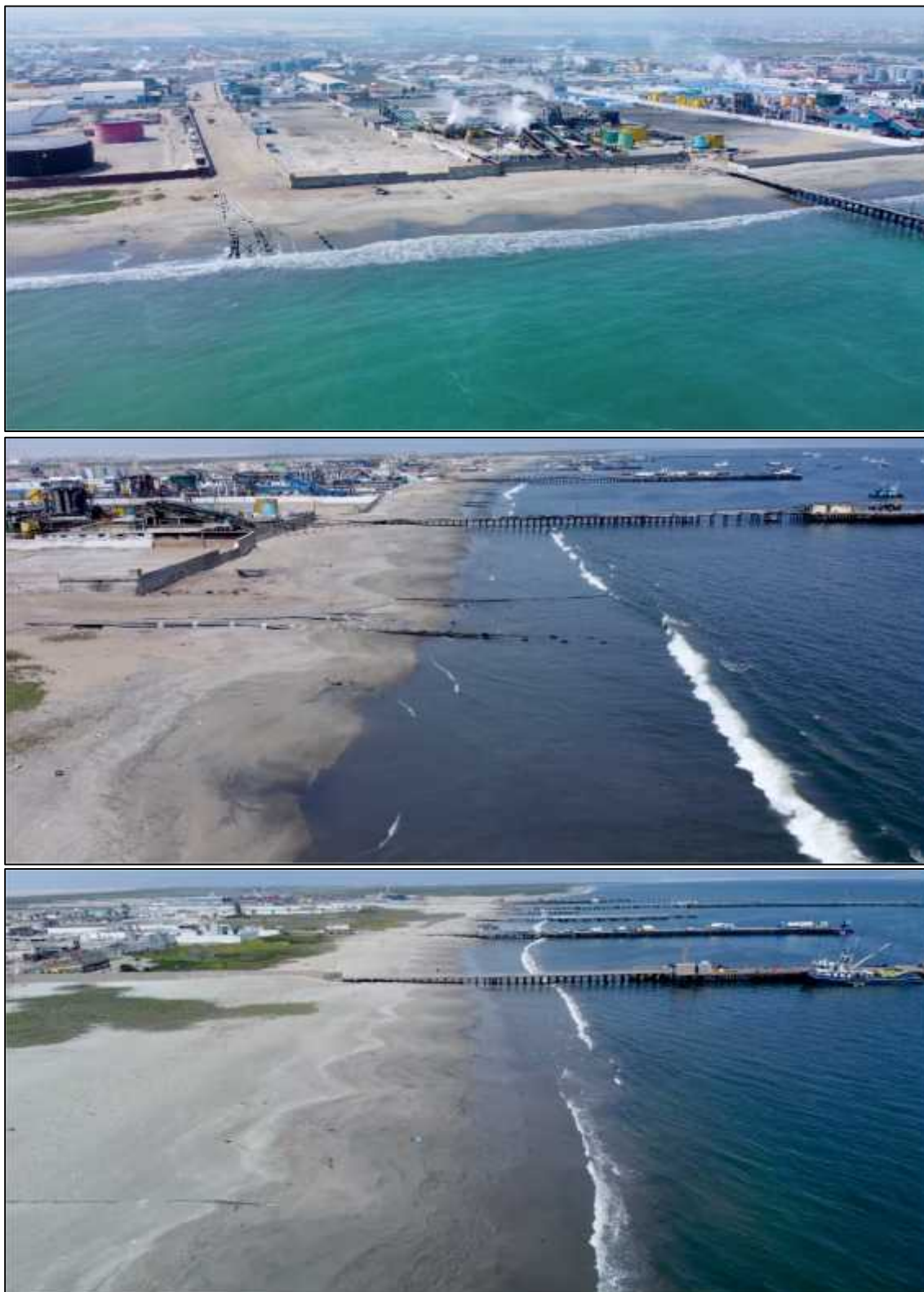
Figura 5: Estado de la playa de la bahía El Ferrol en zona industrial 27 de Octubre en temporada de pesca y veda industrial 2022.
