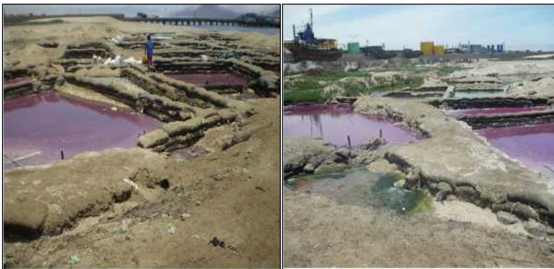
Figura 3: Pozas informales de retención de aceites y grasas, ubicadas en línea de playa, procedente del perforado indebido de canales y tuberías que conducen los vertimientos de aguas residuales industriales pesqueras.
