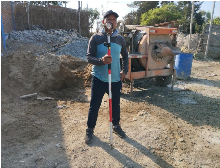
Fotografía N°02: Punto topográfico realizado por personal encargado
