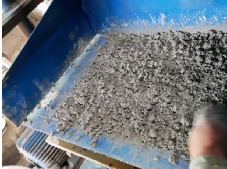
Foto: Muestra la fabricacion de los adoquines de concreto
