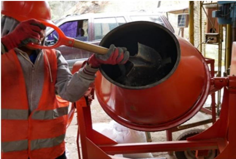
Foto: Muestra la elaboracion del concreto para adoquines
