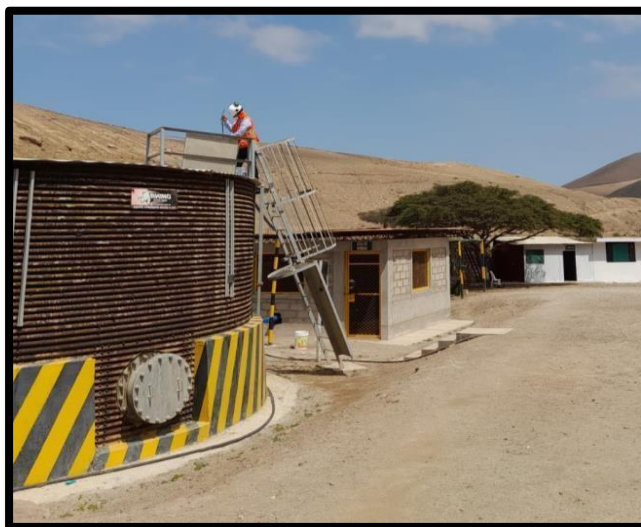
Fig. N°22: Toma de muestra - Agua de Pozo
