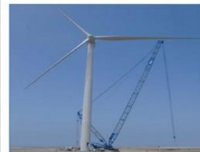
Montaje concluido del Aerogenerador
