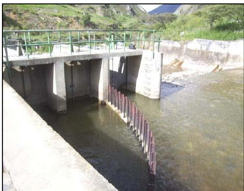
Fig. II.1: Inspección de Bocatoma
