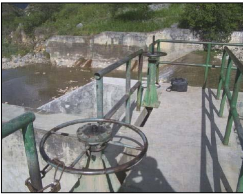
Fig. II.9: Accionamiento de Compuerta
