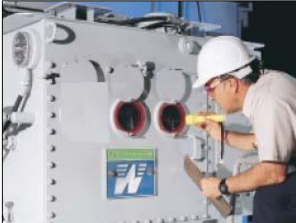
Fig. II.31: Inspección de Transformador de Potencia
