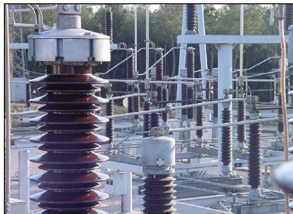
Fig. II.32: Inspección de Patio de Llaves
