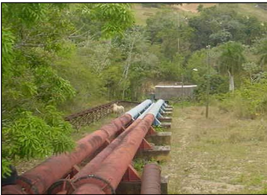
Fig. II.12: Tubería de presión
