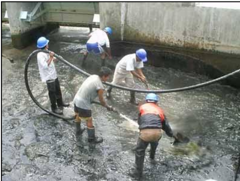
Fig. II.4: Limpieza de Bocatoma
