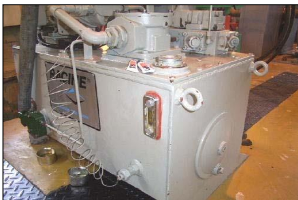
Fig. II.16: Inspección de Sistema hidráulico
