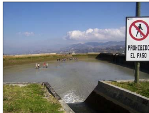
Fig. II.5: Limpieza de Cámara
