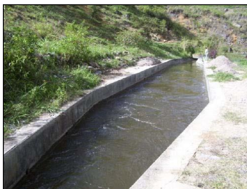
Fig. II.2: Inspección de Desarenador
