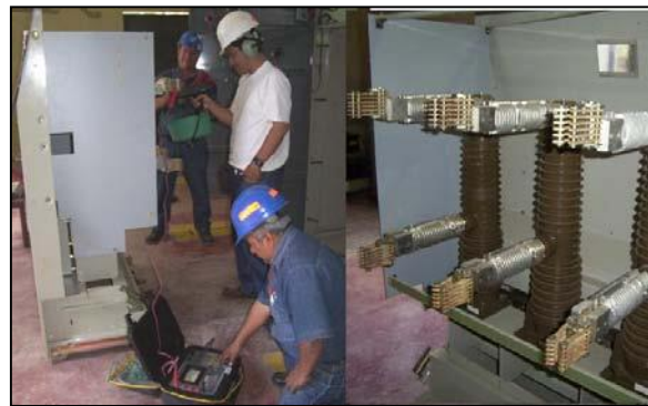
Fig. II.36: Interruptor de potencia
