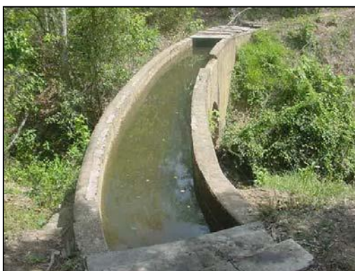
Fig. II.3: Inspección de Canal
