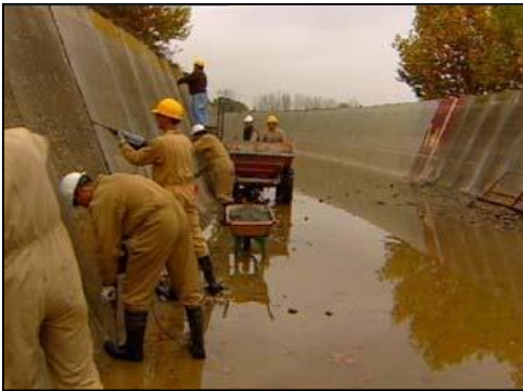
Fig. II.6: Resane en el Canal
