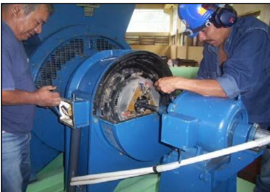
Fig. II.33: Diodos rectificadores
