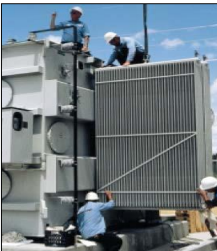
Fig. II.37: Limpieza de Transformador
