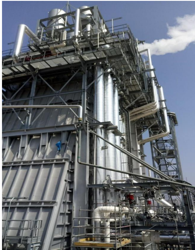
Figura 25: Proceso de instalación de aislamiento térmico
