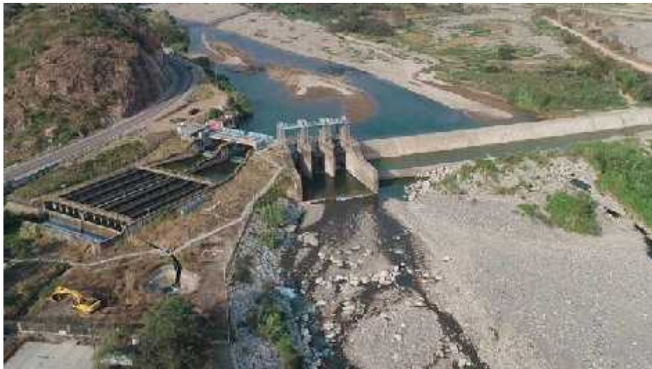
14g. Vista panorámica de la Bocatoma Raca Rumi, se observa los sedimentos acumulados.
