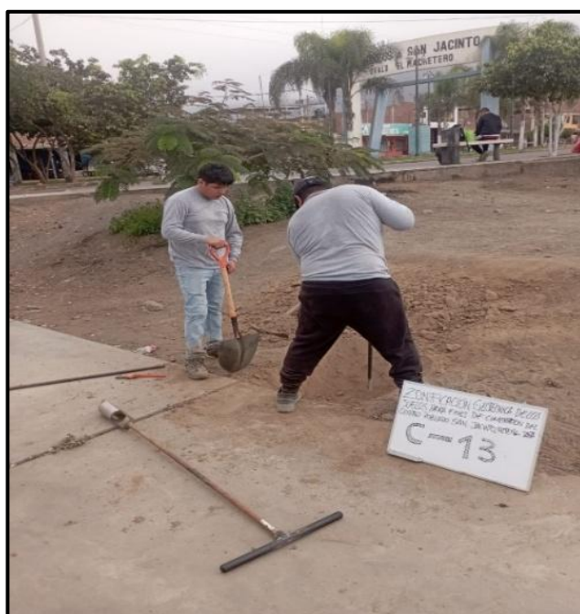
Foto 2: Excavación de calicata (C-13) en distintos sectores del Centro Poblado
