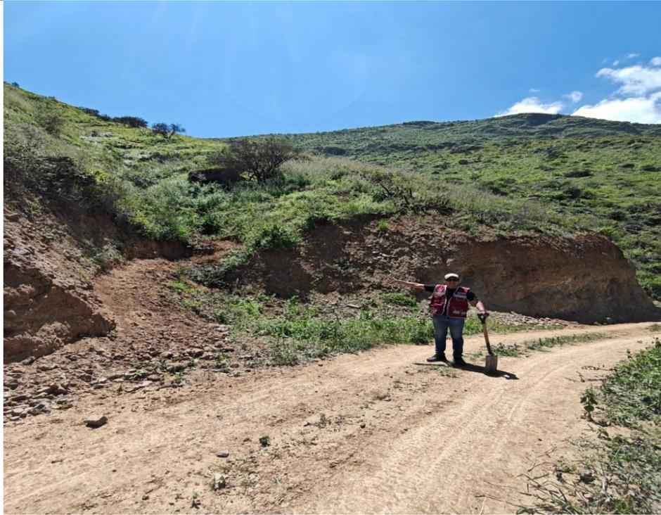
*Fig N° 9.6. Se visualiza la ausencia de estructuras de drenaje en la quebrada N° 03 – Se visualiza deslizamiento y acumulación de sedimentos. – Progresiva 4+550.00 aprox.*
