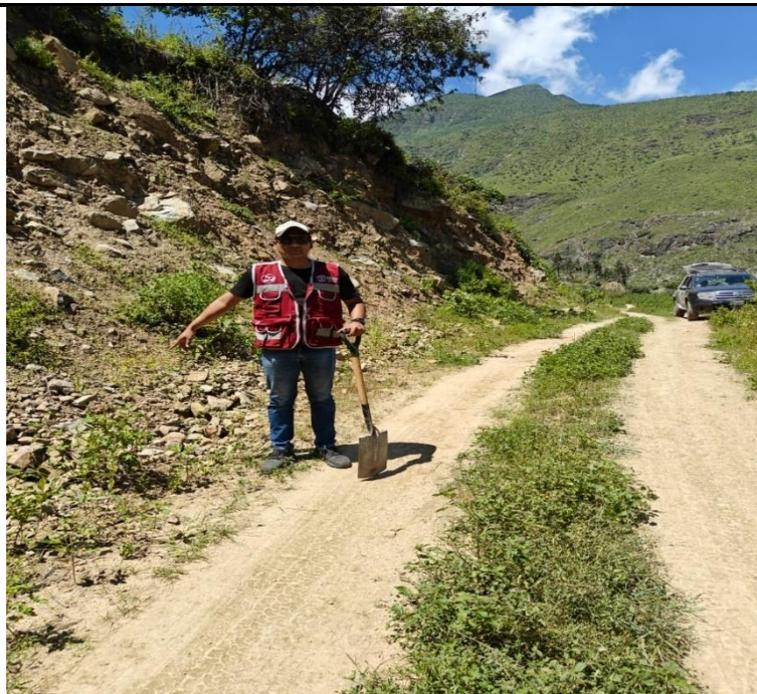
*Fig N° 9.5. Se visualiza la ausencia de sistema de drenaje en la carretera, además de la existencia de maleza en la misma – Prog. 4+958.00 aprox.*
