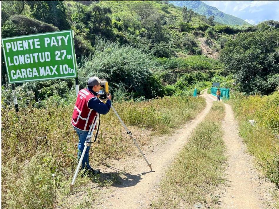
*Fig N° 9.15. Calibración del equipo topográfico luego de cambio de estación con reorientación – Progresiva 0+185*
