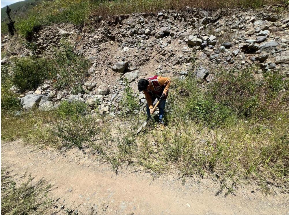
***Fig N° 9.17. Inicio de la elaboración de la Calicata N° 03 en la quebrada N° 01***
