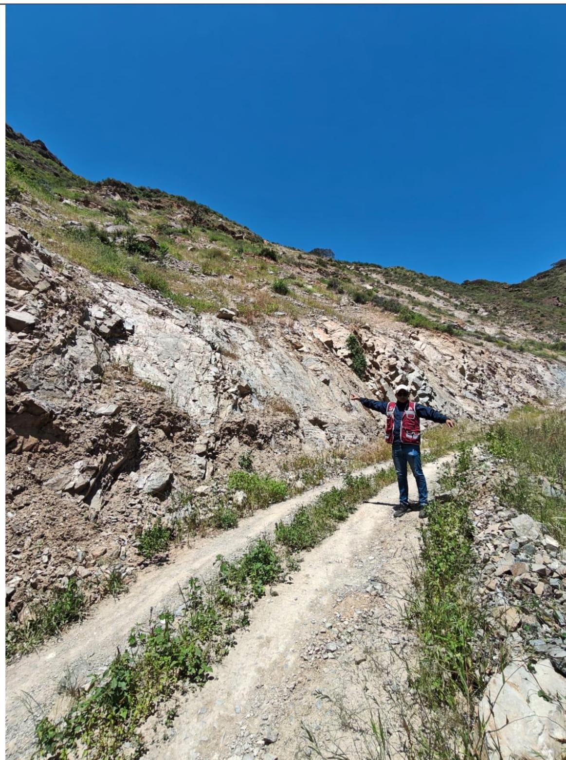
*Fig N° 9.13. Se visualiza la ausencia de estructuras de drenaje en el tramo carretero, así como la acumulación de material sedimentario en los extremos. – Visualización de la Quebrada N° 02 – Progresiva 2+180.00 aprox.*
