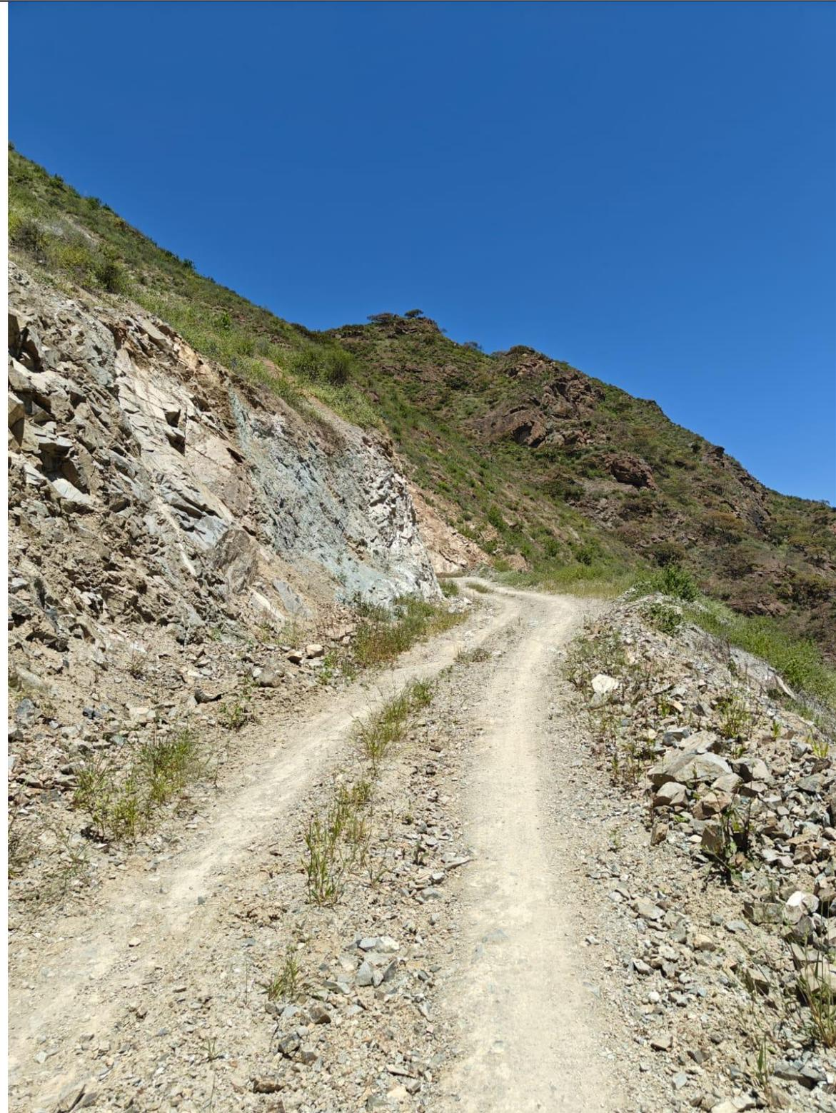
*Fig N° 9.10. Se observa claramente la ausencia de sistema de drenaje alguno comprometiendo la funcionalidad del tramo carretero.*
