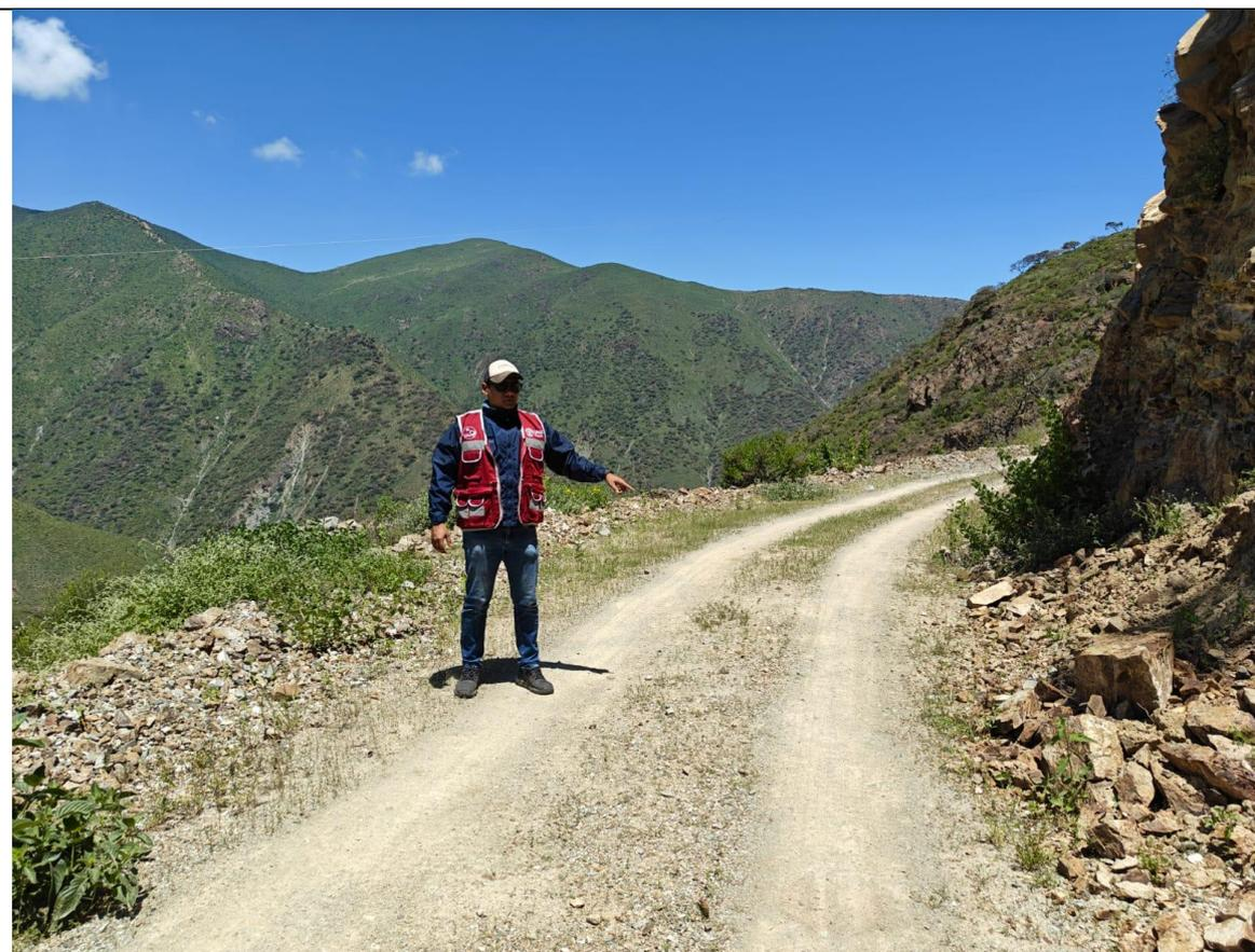
*Fig N° 9.8. Se muestra la ausencia de sistema de drenaje en el tramo carretero – Progresiva 4+520 aprox.*
