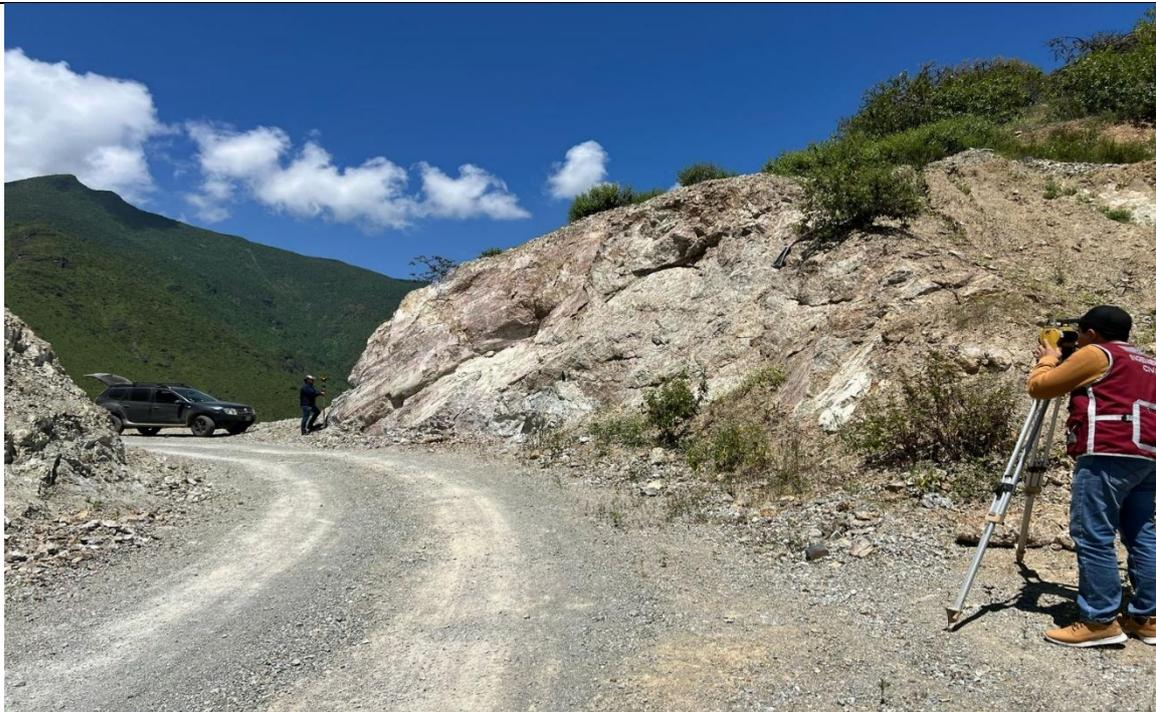
*Fig N° 9.7. Se observa la toma de puntos, en esta ocasión, luego de un cambio de estación con reorientación*
