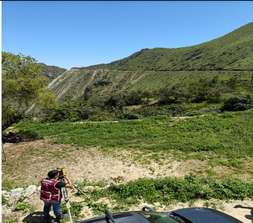
*Fig N° 9.4. Calibración del equipo topográfico – Estación Total – Para inicio de toma de puntos*
