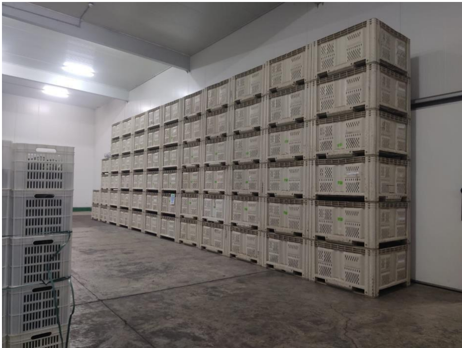
Figura 23 Foto de cámara de recepción con BINES pegados de TAL S.A
