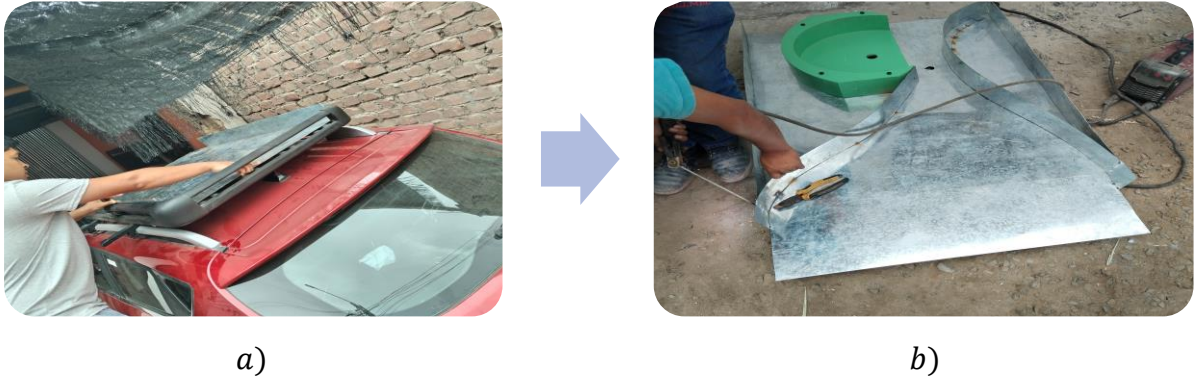
Figura 27: Construcción de la carcasa y conductos de direccionamiento de aire
