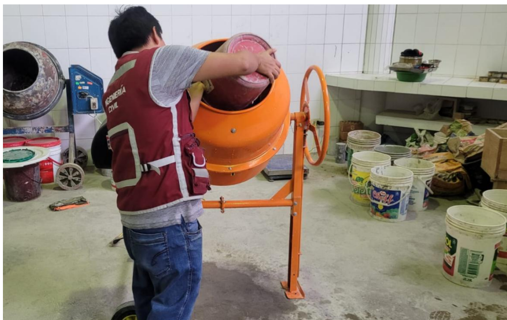
Foto 42. Vaciado de agregados
