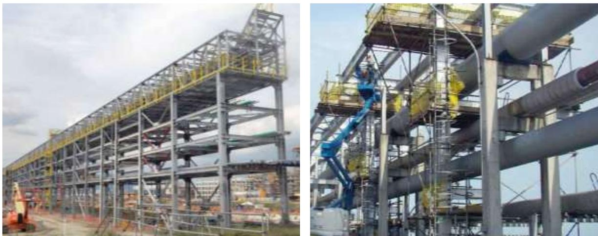
*Nota:* Pipe rack de varios niveles fabricados en concreto y acero. Fuente (www.famsteel.com.br)
