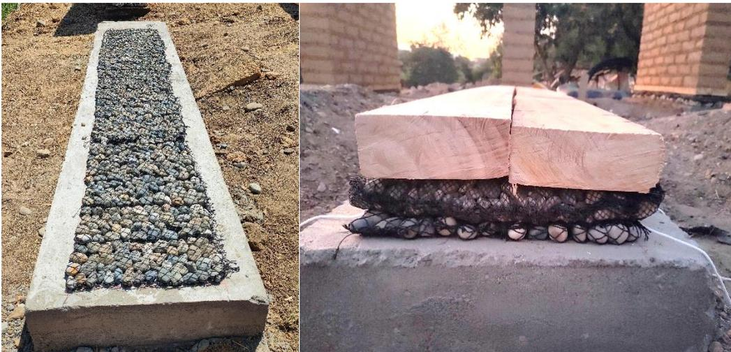
*Nota.* Se observa piedras de 1" rellenas en malla de pecar, y las tres capas que conforman el sobrecimiento del tratamiento T<sub>1</sub>.
