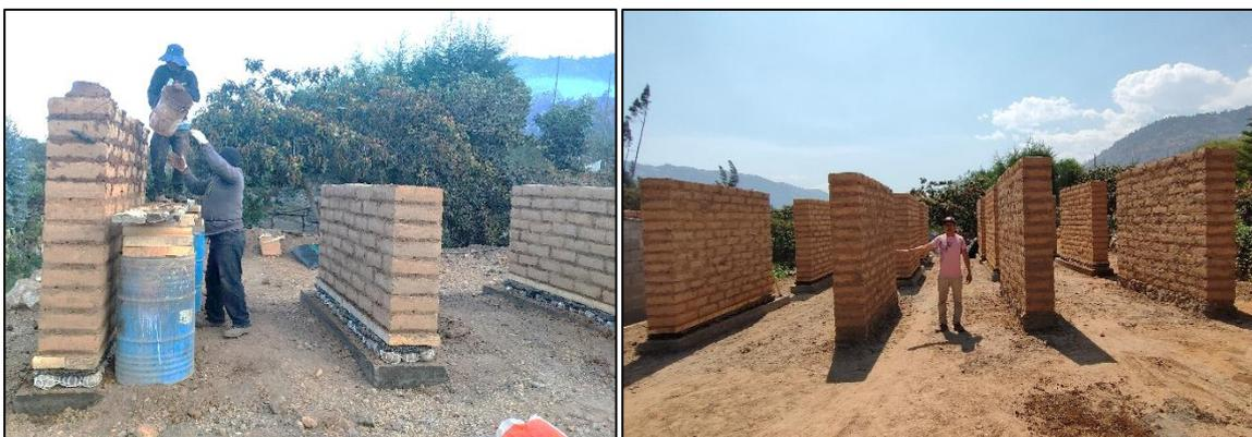
*Nota.* La construcción de los muros se realizó como máximo a una altura de 1 m por jornada.
