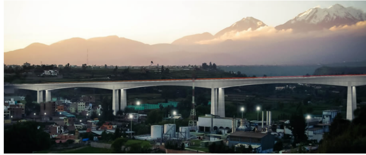
Figura 1.2: Puente Chilina en Arequipa - Perú Apreciamos un puente que tiene una estructura sólida donde los pilones funcionan como amortiguadores.
