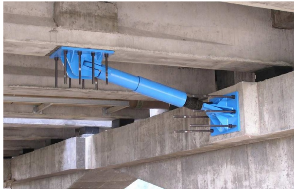
Figura 1.3: Amortiguador bien localizado y óptimo en medida Se observa un amortiguador colocado debajo de un puente. La localización a(x) es buena y la medida g asociada la métrica Riemanniana es óptima.
