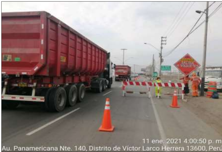
Imagen 11 Señalización y seguridad vial en tramos de desvío Puente Reque.
