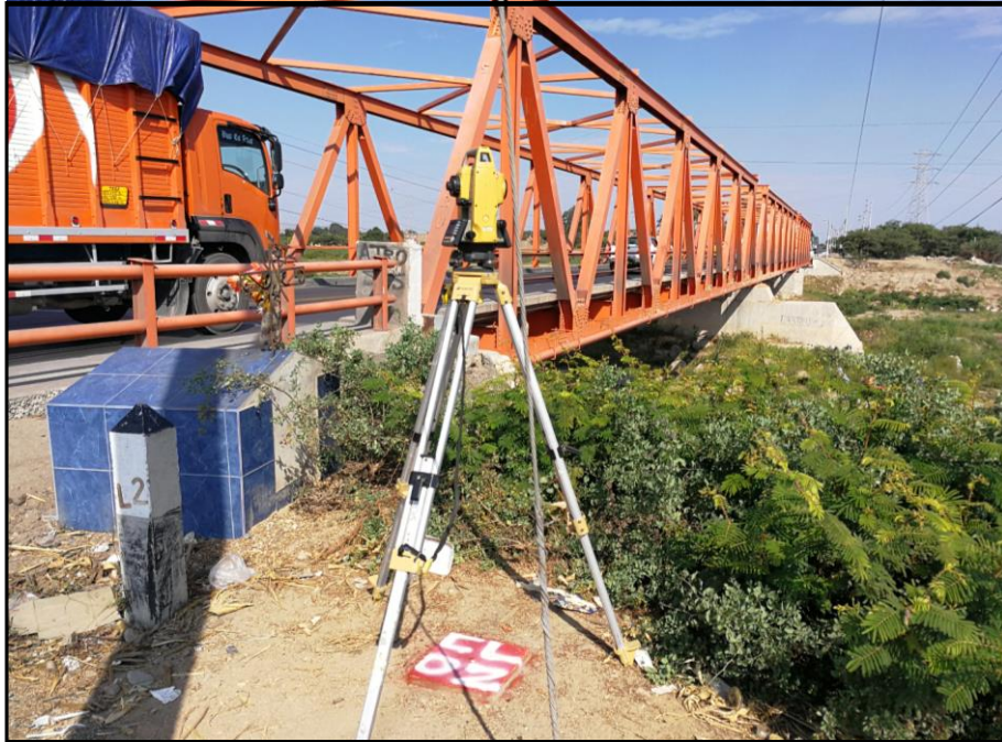
Imagen 09. ESTACION TOTAL TOPCON ES-105. PUNTO DE CONTROL CL-02.
