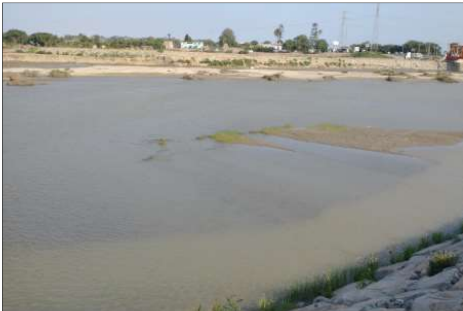
Imagen 4 Aguas Arriba de Puente Reque, cauce de Río Chancay.
