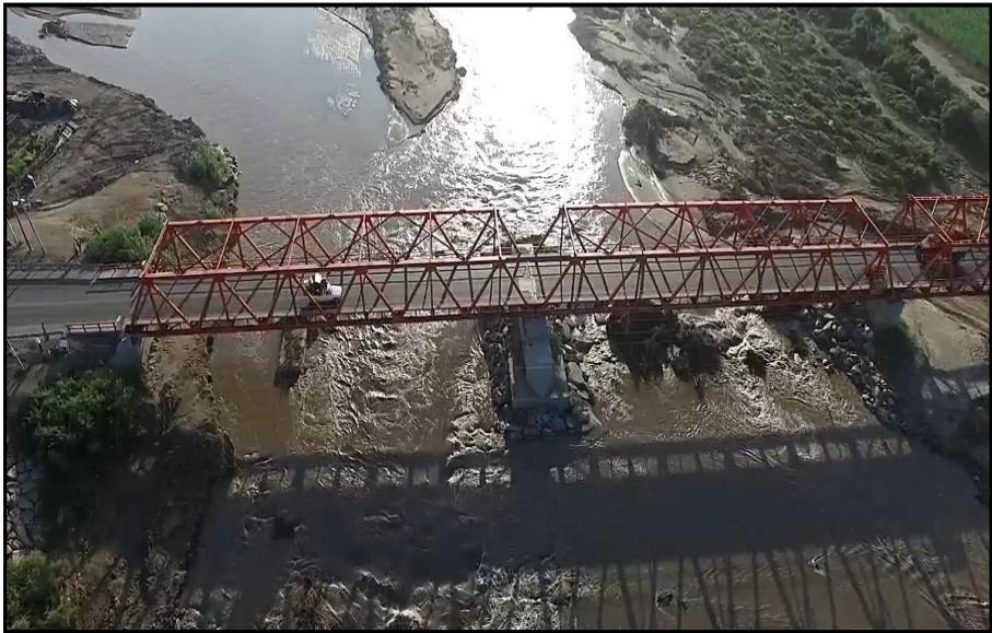
Imagen 2: Vista detallada del puente sobre el río.
