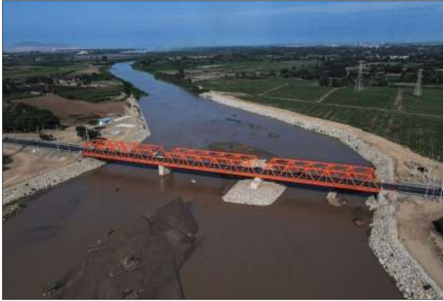
Imagen 1 Vista Panorámica del Puente Reque
