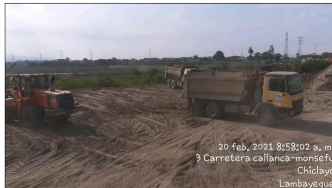
Foto 02: Conformación de DME-Reque
