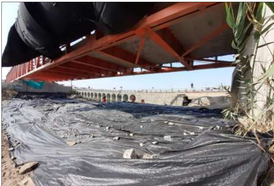
Imagen 10 Colocación de alfombras para proteger el sustrato de la rívera durante trabajos de arenado.
