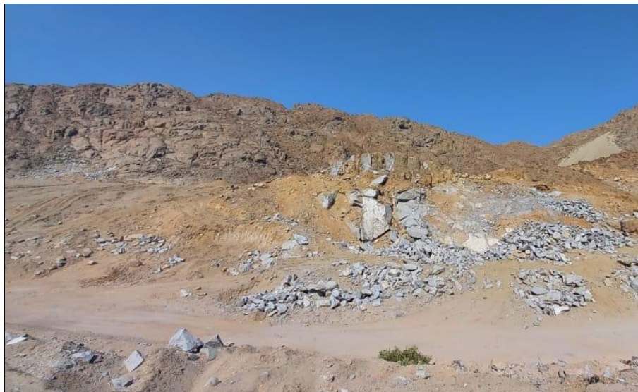
Foto 12. Eliminación de material suelto de laderas
