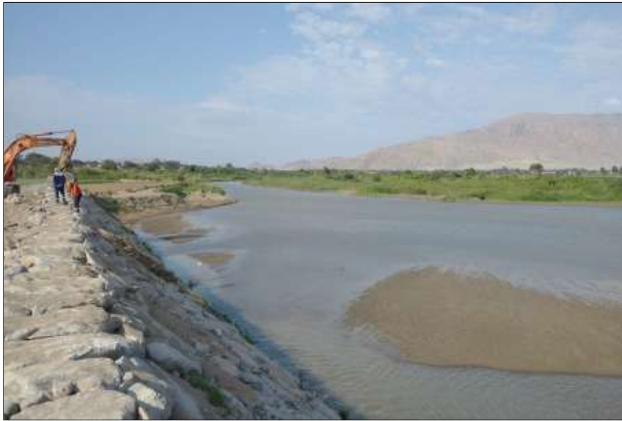
Imagen 3 Aguas Arriba de Puente Reque, cauce de Río Chancay.
