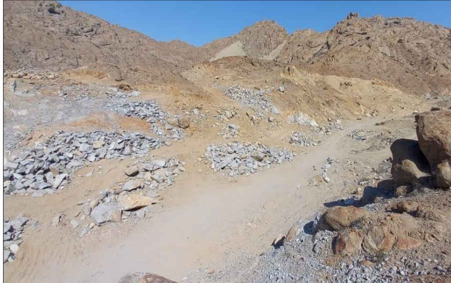
Foto 11. Desmovilización de equipos, maquinarias de laderas de cantera.
