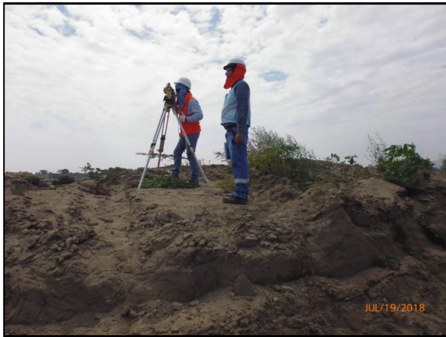
Imagen 10. SUPERVISOR DE CAMPO VERIFICANDO LA TOMA DE DATOS DEL TERRENO.
