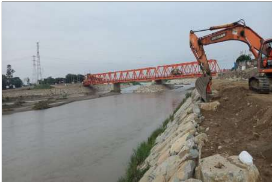
Imagen 8 Enrocado, defensas rivereñas de Puente Reque
