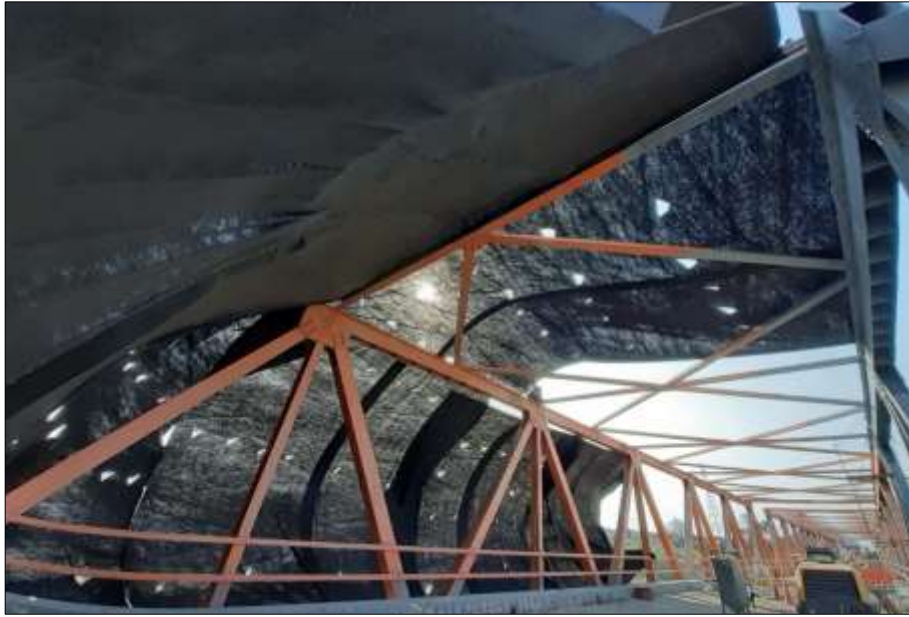
Imagen 9 Colocación de manta protectora para evitar polución durante trabajos de arenado
