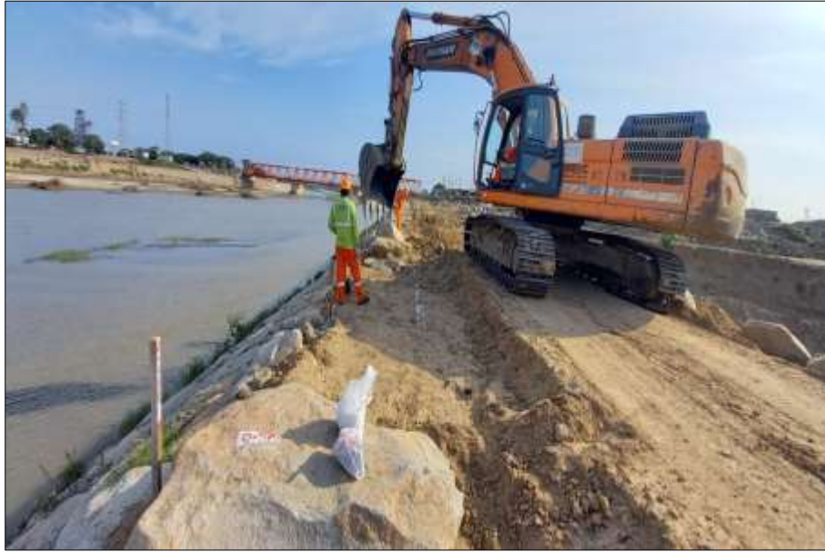
Imagen 7 Enrocado, defensas rivereñas de Puente Reque
