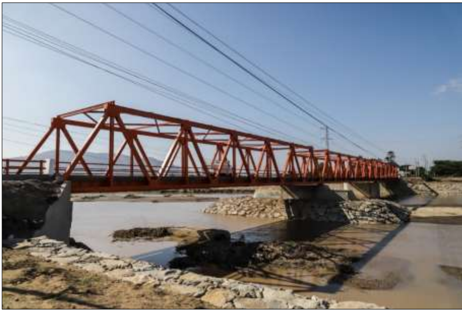
Imagen 2 Vista Lateral del Puente Reque, Margen derecho.
