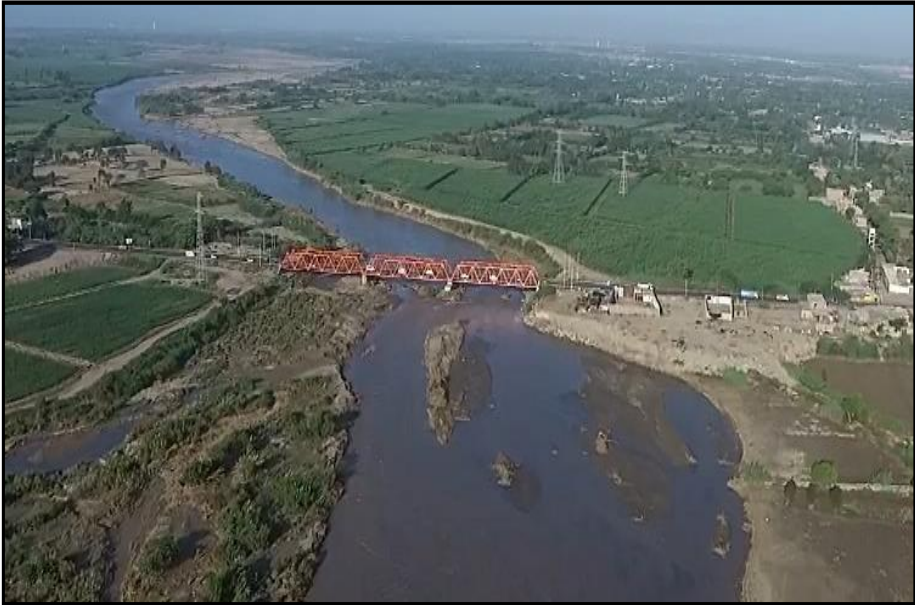
Imagen 1: Vista aérea del río y el puente.
