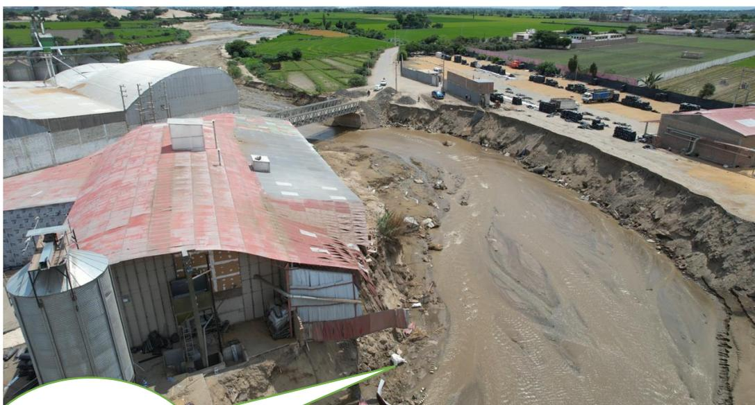
Margen izquierda, socavación afectación a la vivienda, molino de arroz
