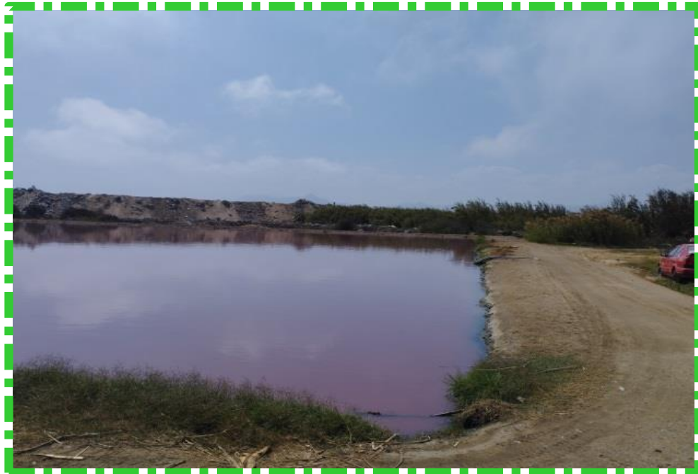
Figura N° 32: Laguna de oxidación “Las Gaviotas”
