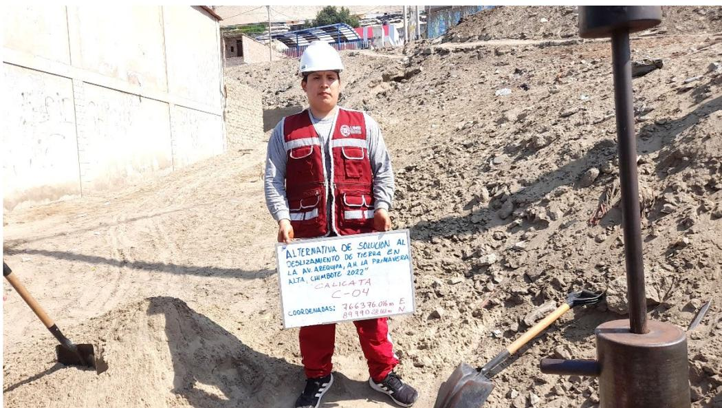
Fotografía N°16.- Excavación de calicata 4
