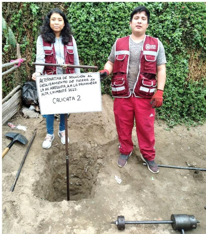
**Fotografía N°14.-** Excavación de calicata 2
