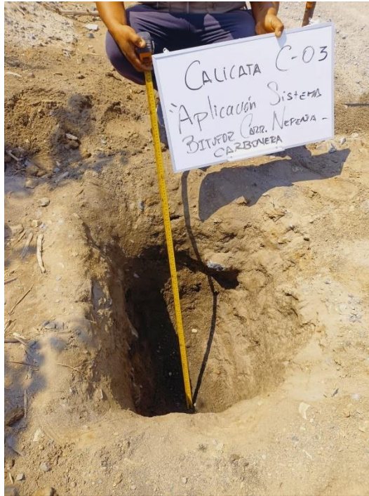
Foto N° 03: Excavación de la calicata N° 03
