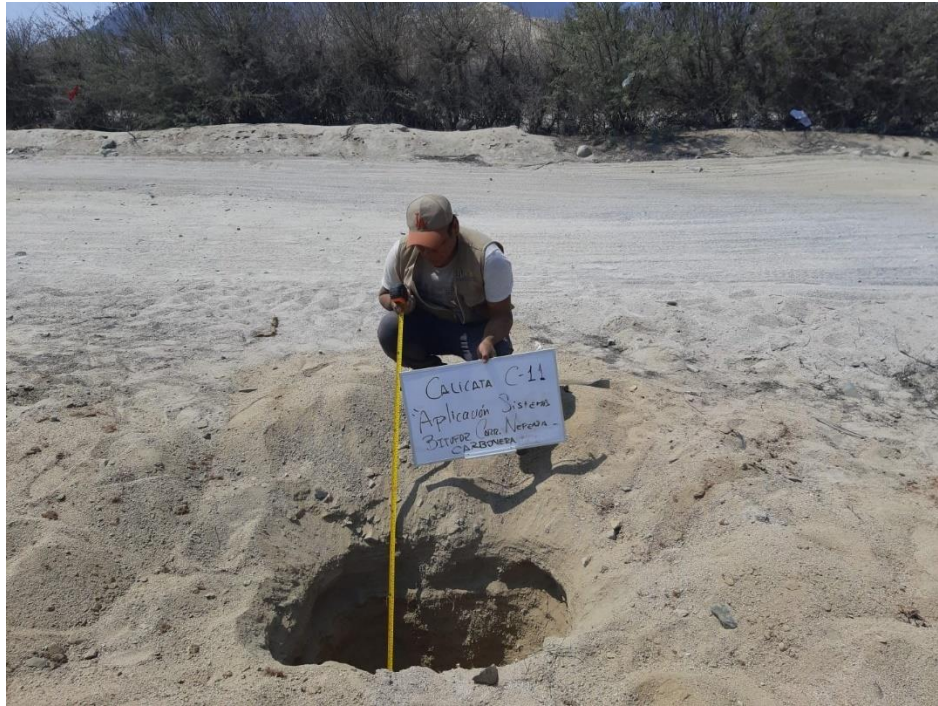
Foto N° 11: Excavación de la calicata N° 11
