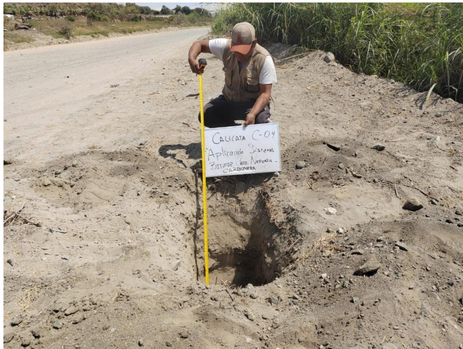
Foto N° 04: Excavación de la calicata N° 04
