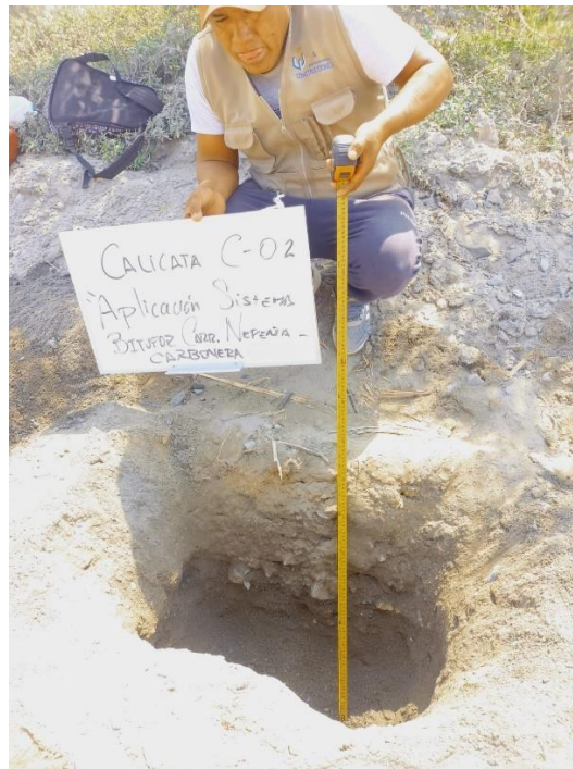
Foto N° 02: Excavación de la calicata N° 02
