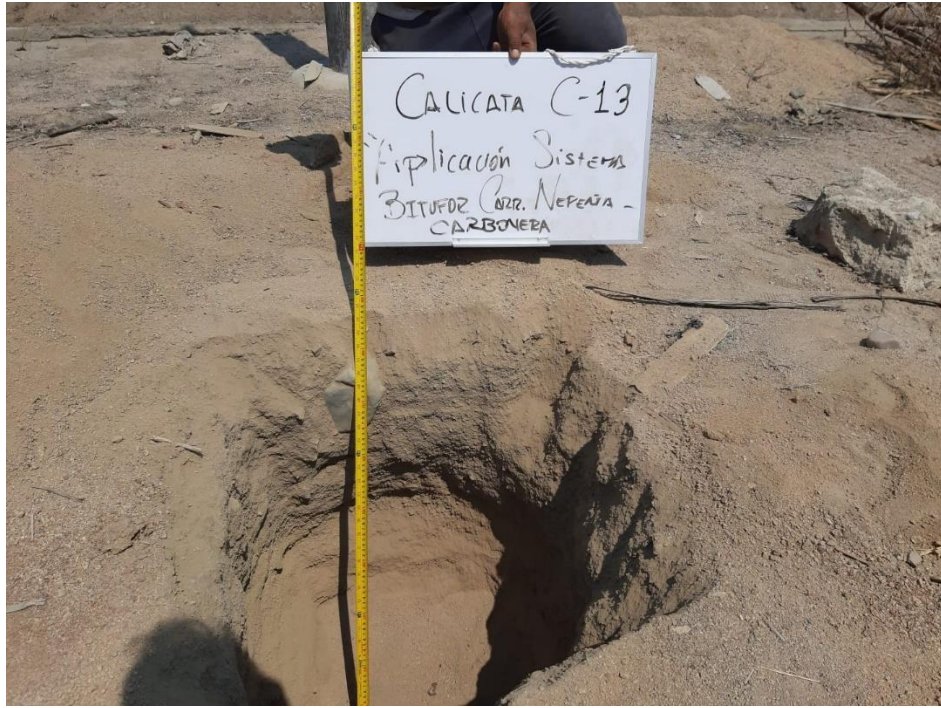
Foto N° 13: Excavación de la calicata N° 13
