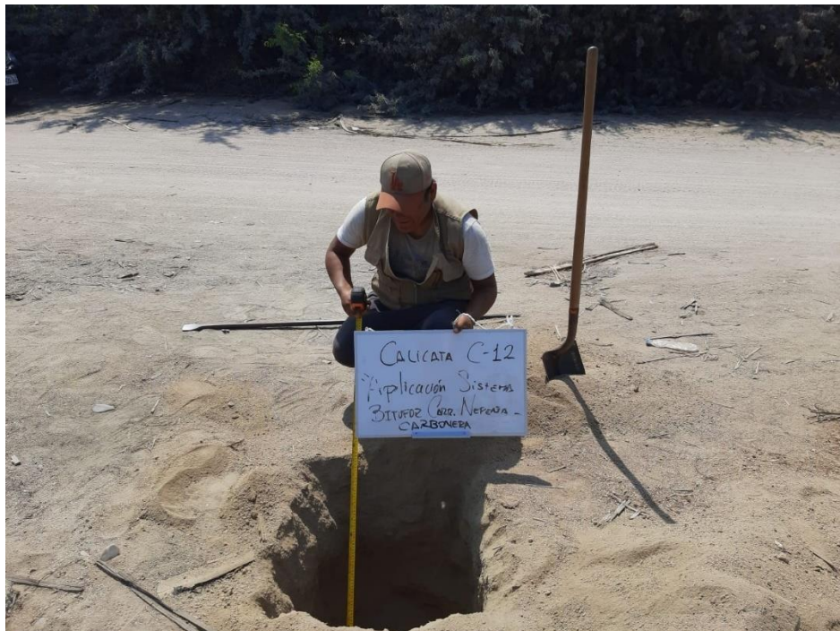
Foto N° 12: Excavación de la calicata N° 12
