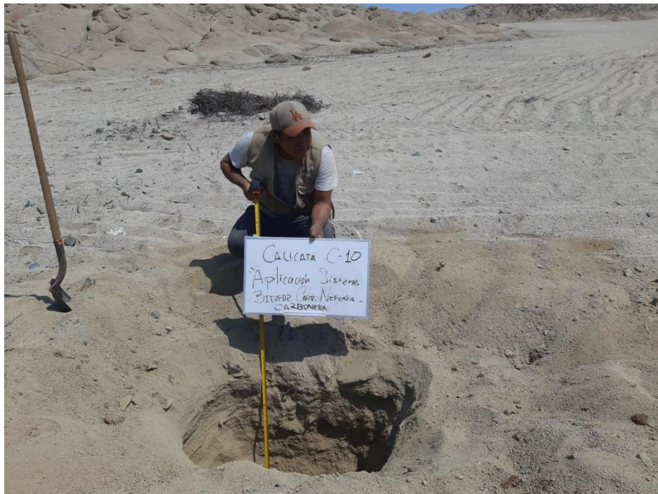
Foto N° 10: Excavación de la calicata N° 10
