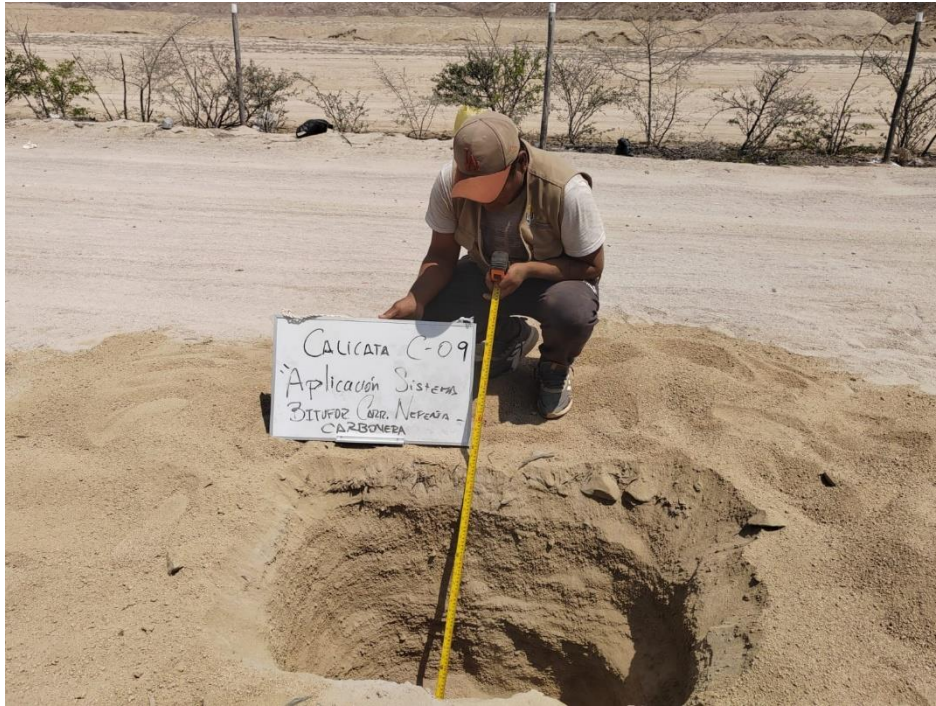
Foto N° 09: Excavación de la calicata N° 09
