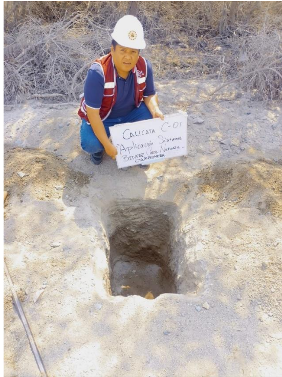
Foto N° 01: Excavación de la calicata N° 01
