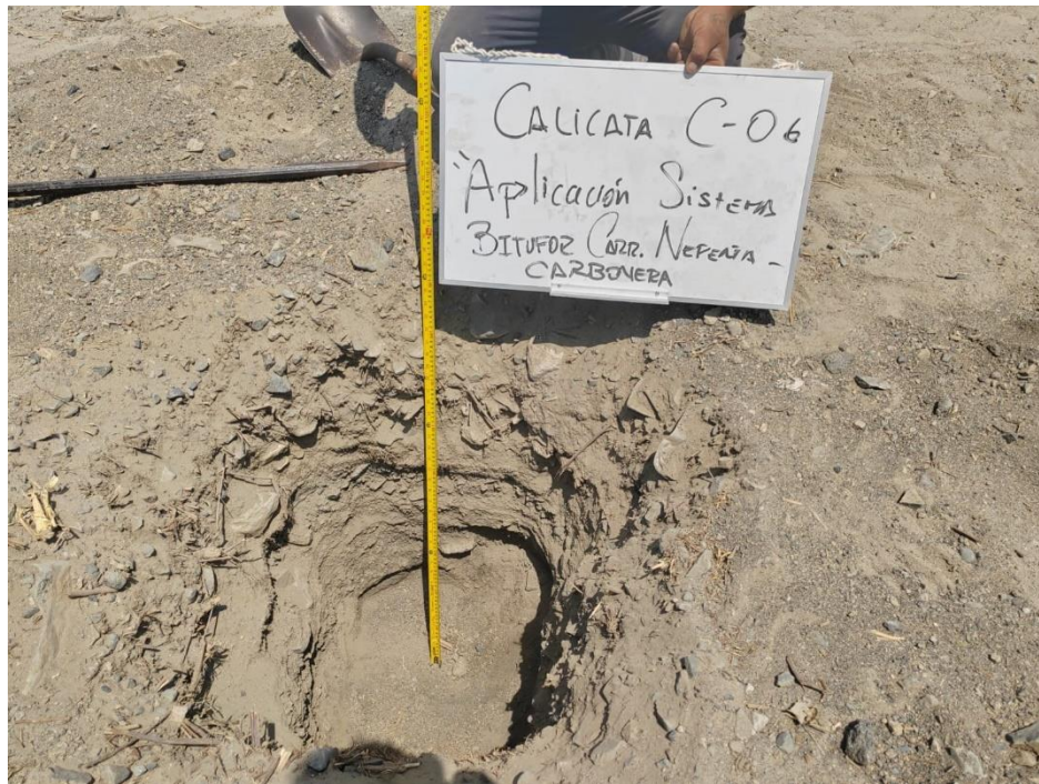
Foto N° 06: Excavación de la calicata N° 06
