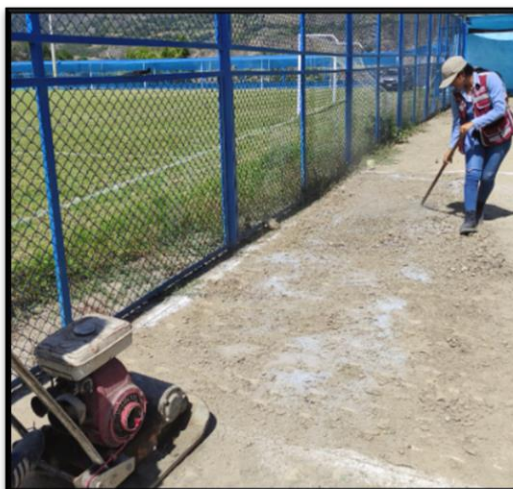
Fotografía 31 Homogenización de la mezcla de ceniza de coronta de maíz y cal con el suelo de la subrasante del tramo de prueba.
