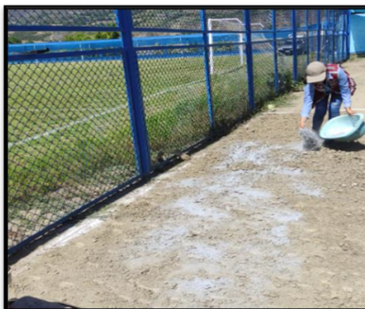
Fotografía 31 Homogenización de la mezcla de ceniza de coronta de maíz y cal con el suelo de la subrasante del tramo de prueba.
