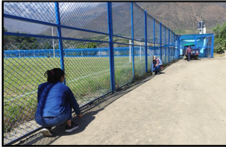
Fotografía 23 Demarcación del tramo de prueba, con un área de 3m x 6m
