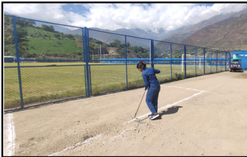
Fotografía 28 Escarificación y homogeneización de la subrasante del tramo de prueba
