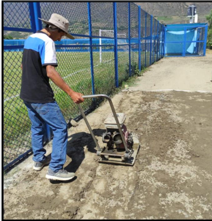
Fotografía 34 Compactación del tramo de prueba usando una plancha compactadora
