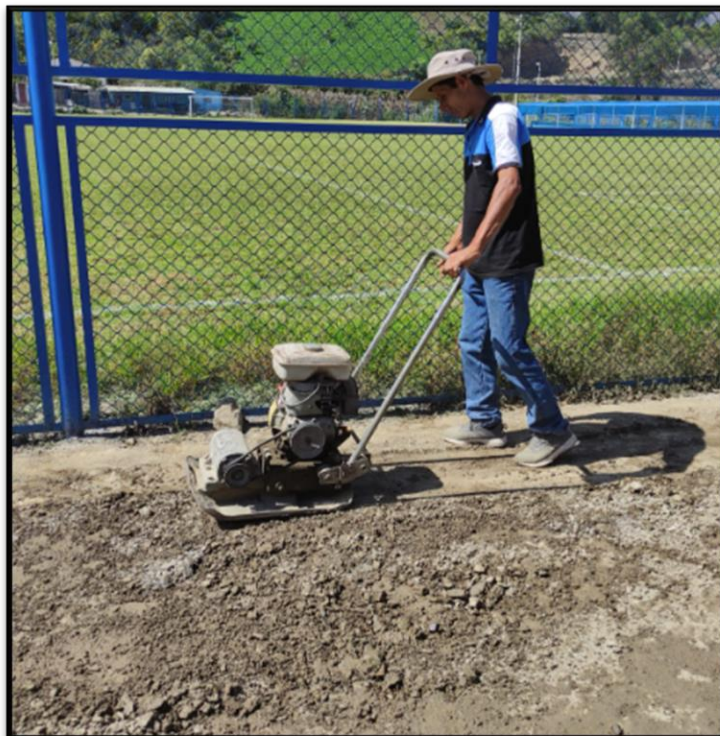
Fotografía 33 Compactación del tramo de prueba usando una plancha compactadora
