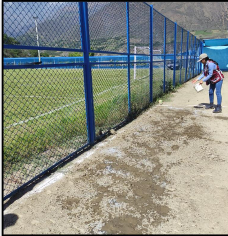
Fotografía 32 Humedecimiento del suelo de la subrasante después de la escarificación del material hasta llevarlo a una condición de \pm 2\% con respecto a la humedad óptima de compactación obtenida mediante ensayo en laboratorio.
