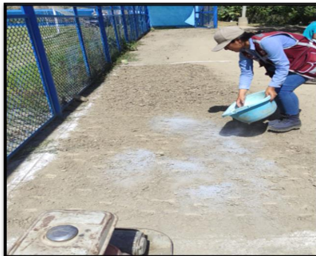
Fotografía 30 Tendido manual de la mezcla de ceniza de coronta de maíz y cal en el tramo de prueba a estabilizar, para ser mezclado con el suelo en estudio.
