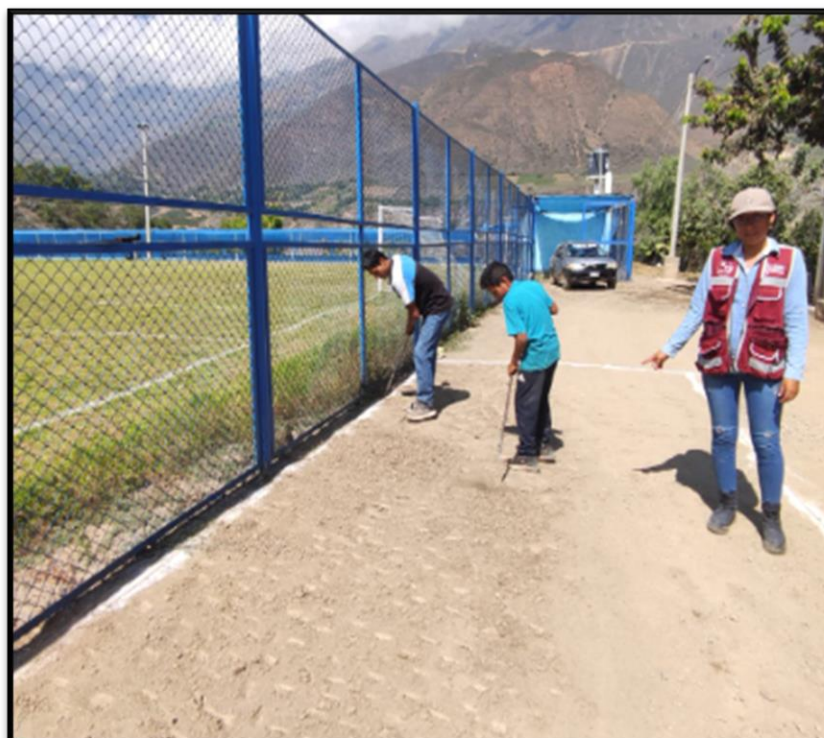
Fotografía 29 Escarificación y homogeneización de la subrasante del tramo de prueba
