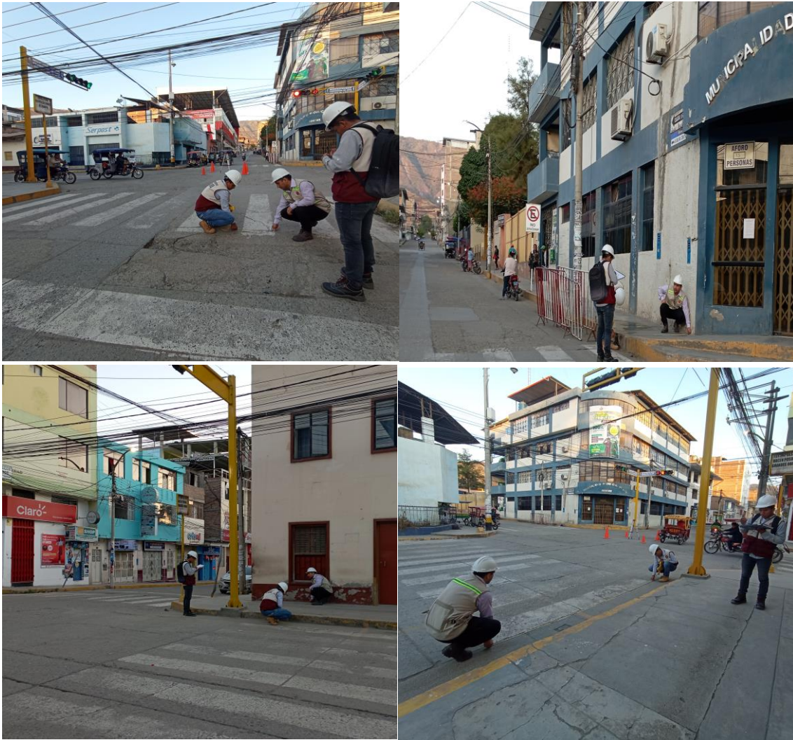
Figura 41: Control y señalización en intersección de calles
