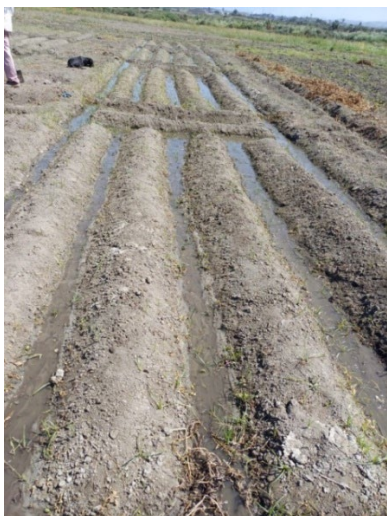
Anexo 20. Instalación de tubos PVC en las entradas de riego
