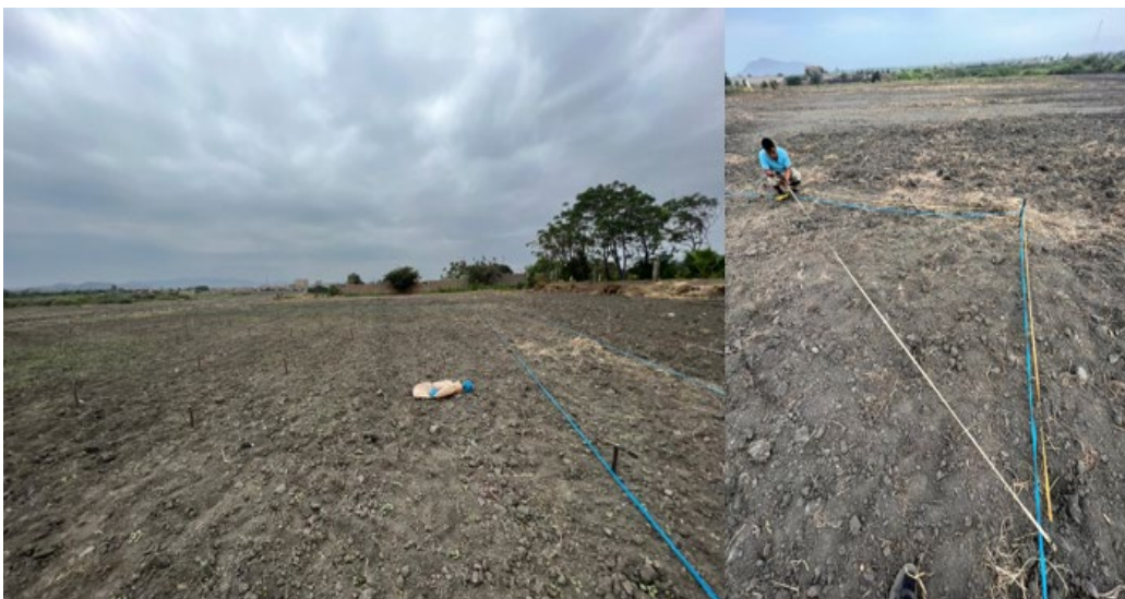
Anexo 5. Delimitación del terreno y aplicación del triángulo 3,4 y 5
