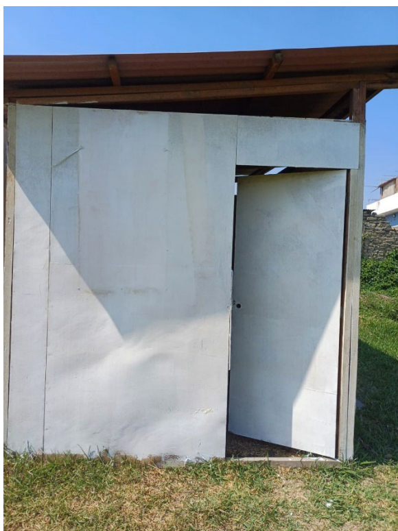
Anexo 65. Almacén donde se guardaron materiales, insumos y equipos
