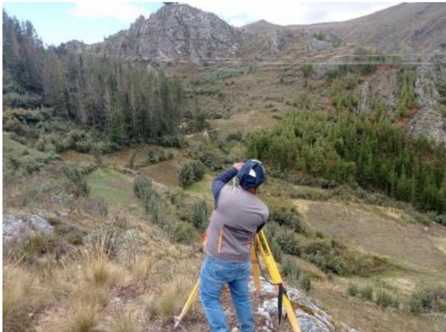
Foto 4: Se observa al topógrafo tomando los puntos topográficos del eje del río
