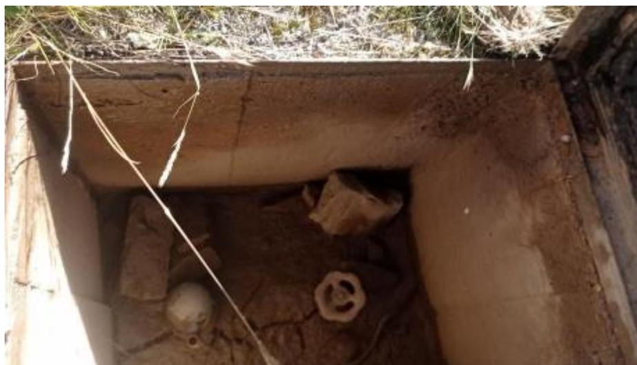
Foto 8 – 9: Se visualiza válvulas de control y de aire en mal estado y sin mantenimiento.
