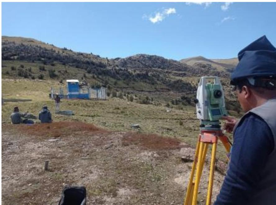
Foto 2: Se distingue al ayudante con su prisma para la toma de datos topográficos
