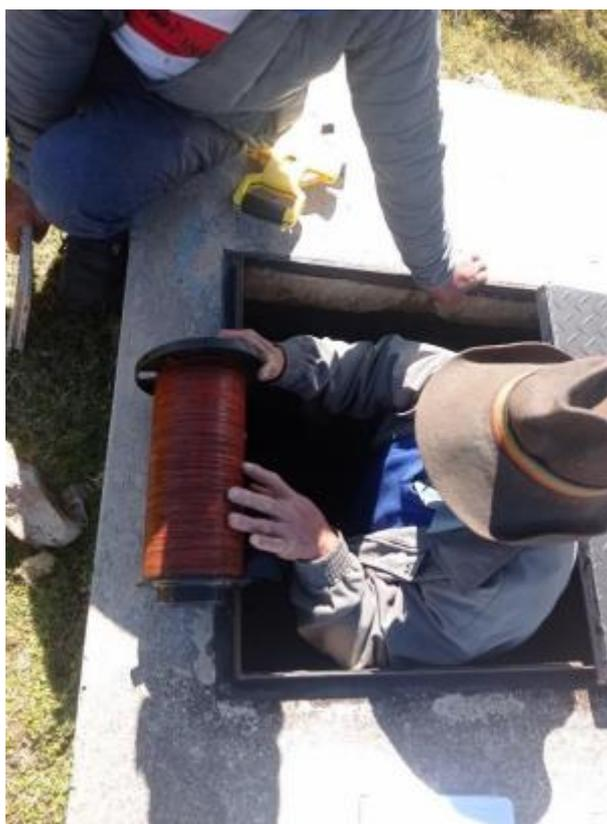
Foto 5 – 6: Se visualiza la caja de filtrado existente perteneciente al reservorio  $v=200$  m<sup>3</sup>, donde es necesario el cambio de filtro de anillas.
