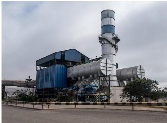
Figura 05. Horno de Arco Eléctrico y Captadora de Humos.
