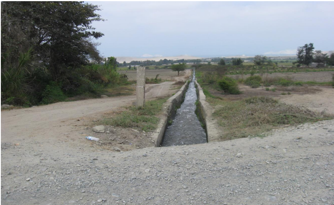
Figura 36: Tramo inicial con fuerte pendiente del canal compuerta 23
