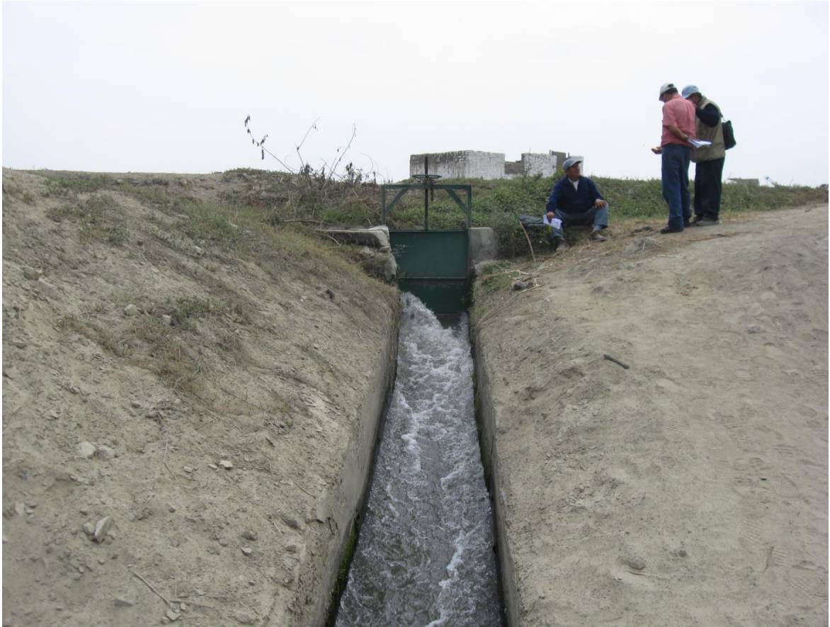
Figura 35: Salida de la toma del canal compuerta 23, flujo de régimen turbulento
