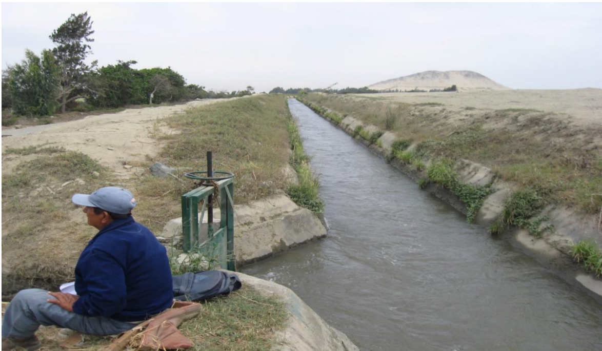
Figura 34: Toma lateral de la compuerta 23; km 26+754
