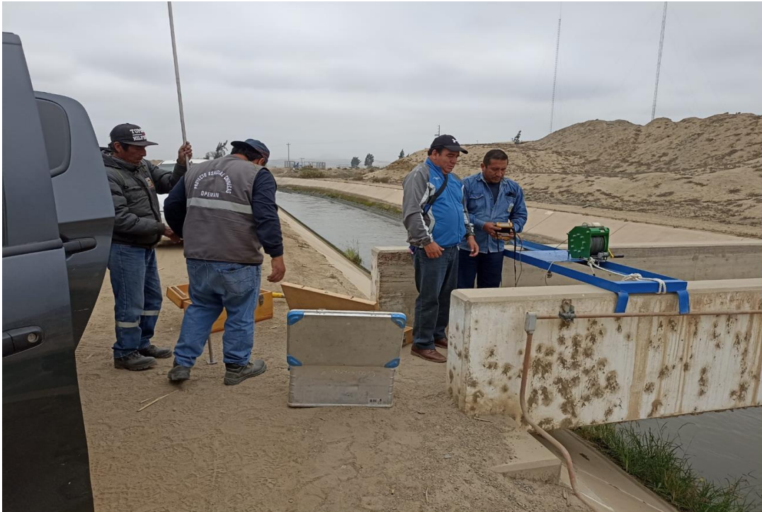
Figura 28 Instalación de la base para colocar el correntómetro Valeport
