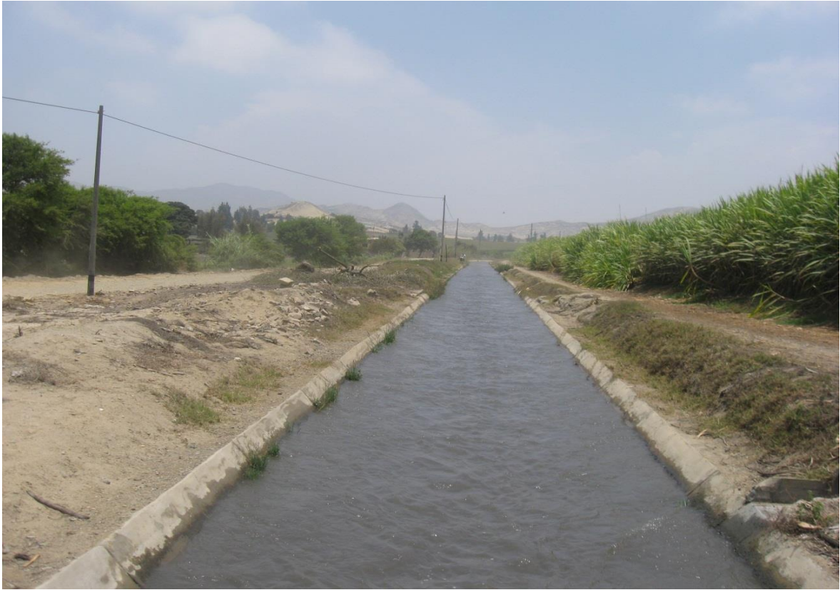
Figura 37: Canal Carlos Leight de primer orden que abastece al canal de segundo orden
