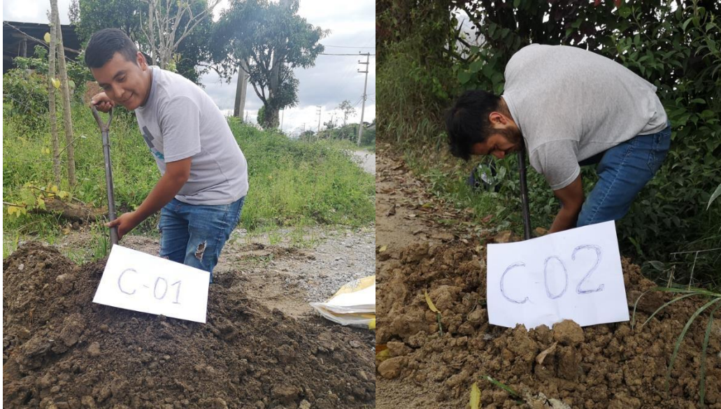
Foto 01: Realizando las excavaciones de las calicatas para obtener las muestras a estudiar
