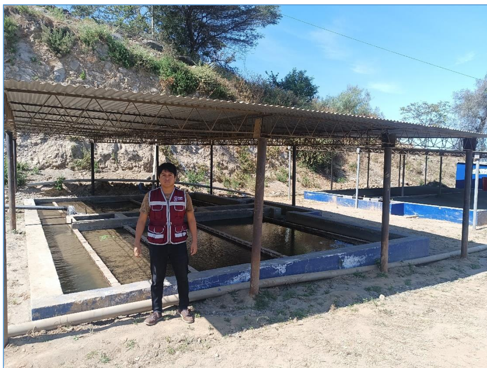
Prefiltros de grava del Centro Poblado de Jimbe
