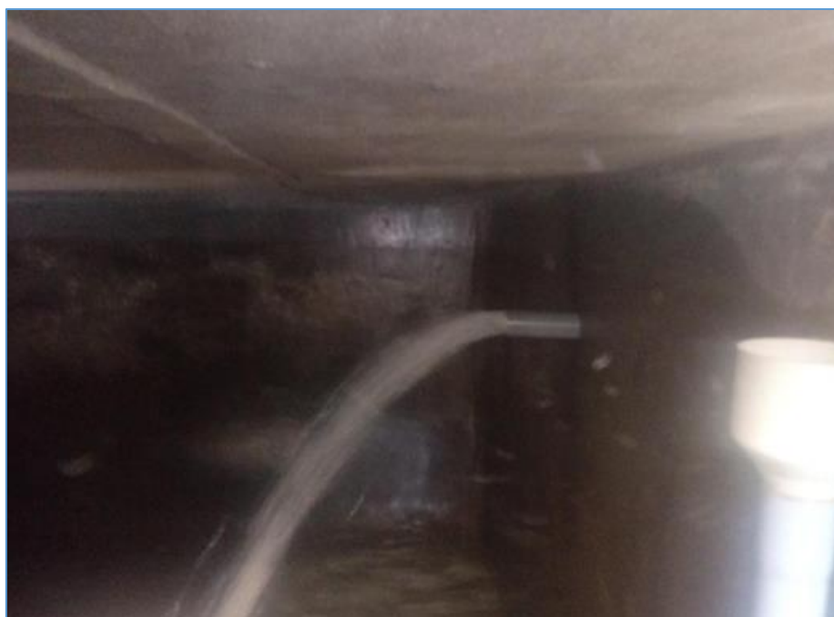
Interior del reservorio de C.P. Macracancha
