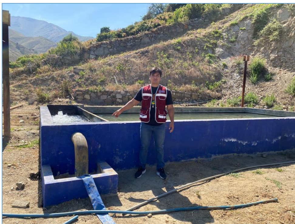
Sedimentador del Centro Poblado de Jimbe
