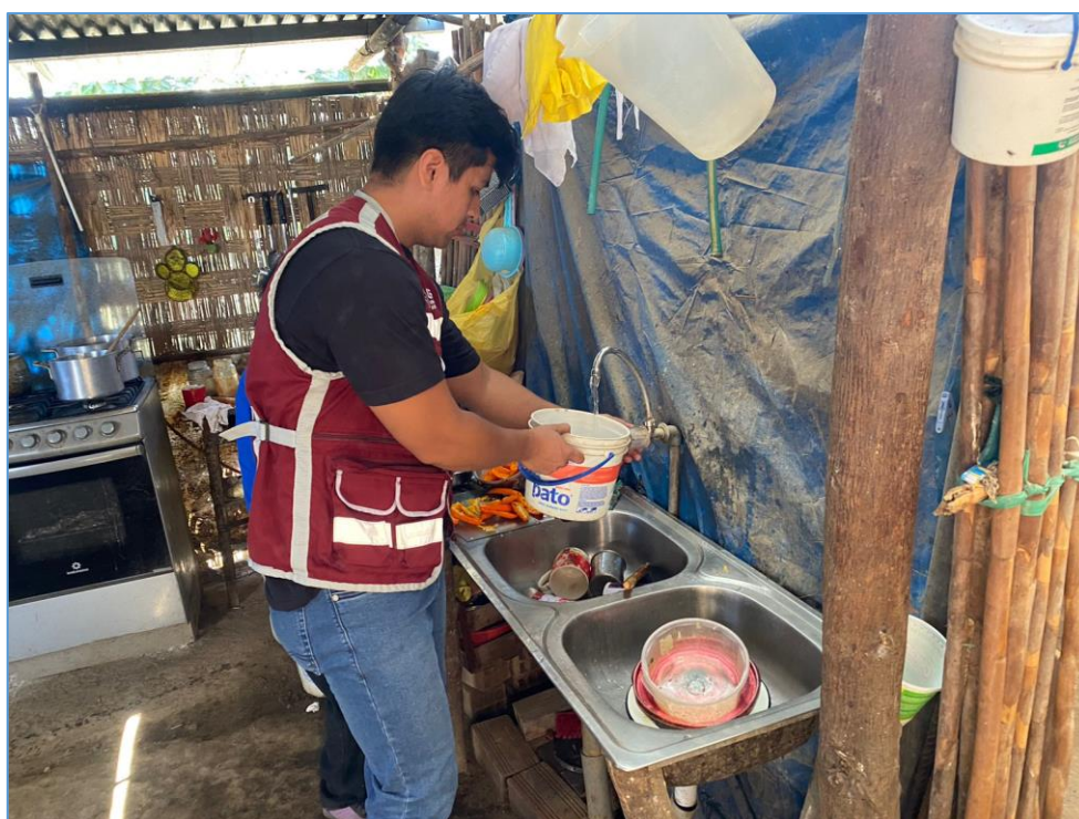
Aforo volumétrico de vivienda 01 en C.P. Jimbe
