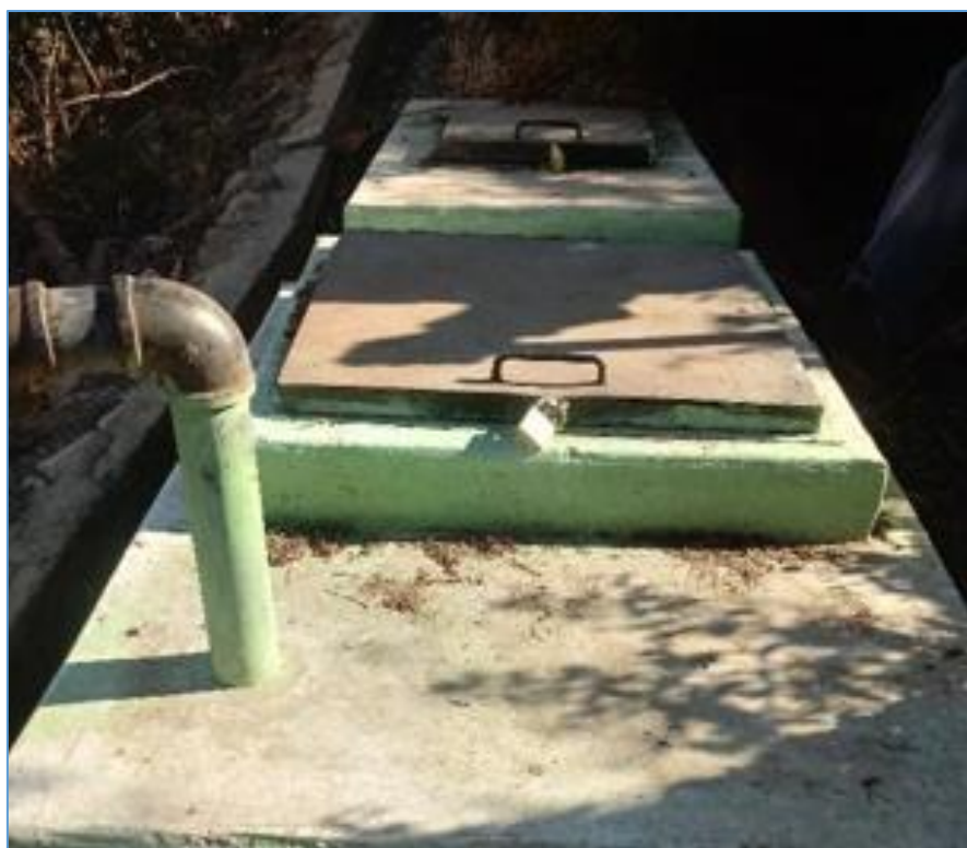
Cámara rompe presión tipo VI C.P. Salitre
