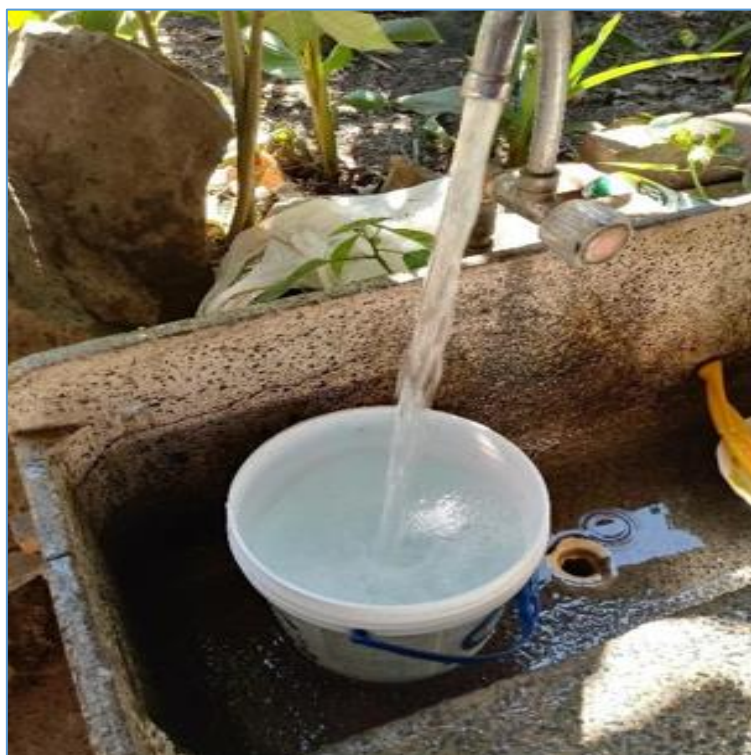
Aforo volumétrico de vivienda 01 del C.P. Salitre
