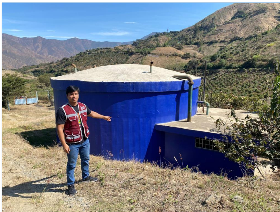
Reservorio del Centro Poblado de Jimbe
