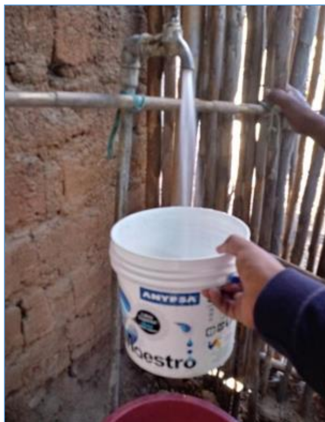
Aforo volumétrico en vivienda C.P. Nueva Victoria
