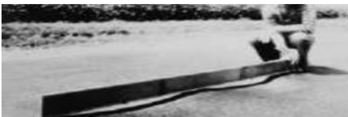
Figura 15. Corrugación -Severidad High
