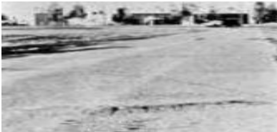
Figura 11. Abultamiento -Severidad Medium
