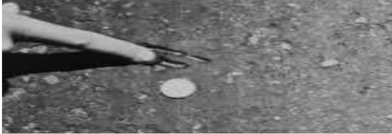
Figura 5. Exudación -Severidad Medium
