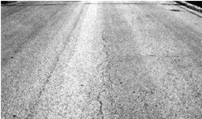
Figura 1. Piel de cocodrilo -Severidad Low
