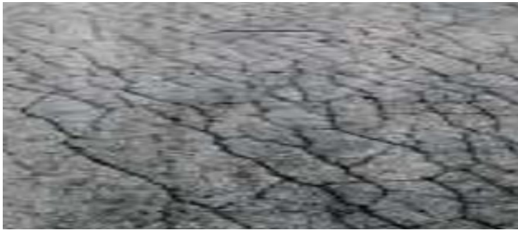
Figura 2. Piel de cocodrilo -Severidad Medium
