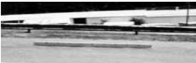
Figura 14. Corrugación -Severidad Medium
