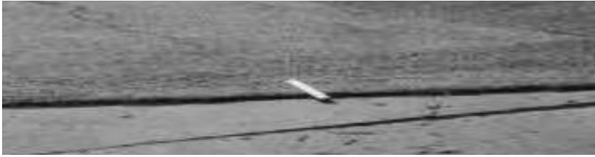
Figura 42. Desplazamiento-Severidad Medium
