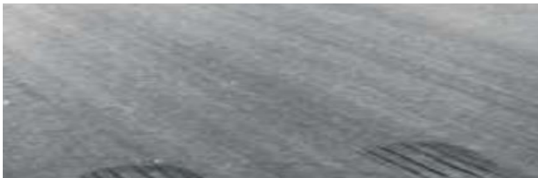
Figura 6. Exudación -Severidad High
