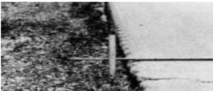
Figura 27. Desnivel carril-berma -Severidad High
