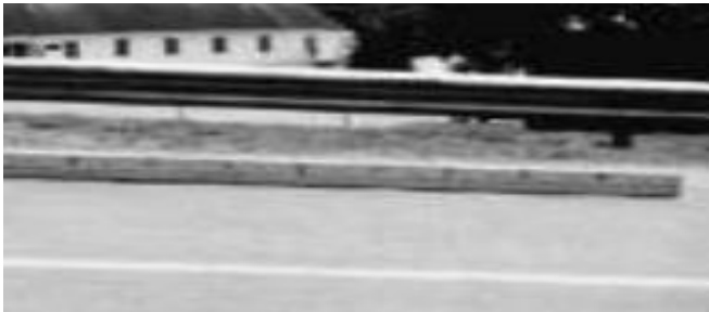
Figura 13. Corrugación -Severidad Low
