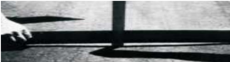
Figura 17. Depresión -Severidad Medium
