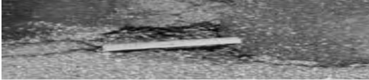
Figura 35. Baches-Severidad Low
