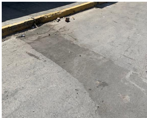
Abultamientos y hundimientos
