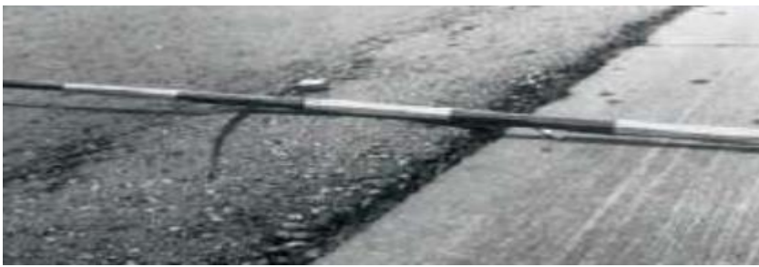
Figura 43. Desplazamiento-Severidad High
