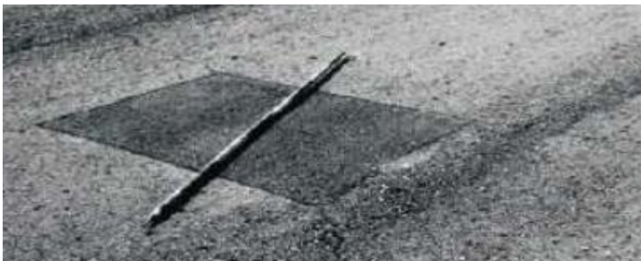
Figura 31. Parches y parches de cortes utilitarios -Severidad Low
