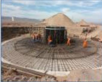
Colocación de Acero de Fundación Aerogenerador N° 48
