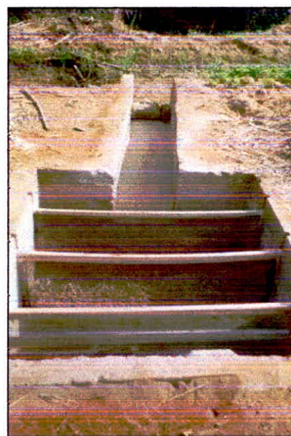
Fig. 9 Filtro - flujo horizontal
