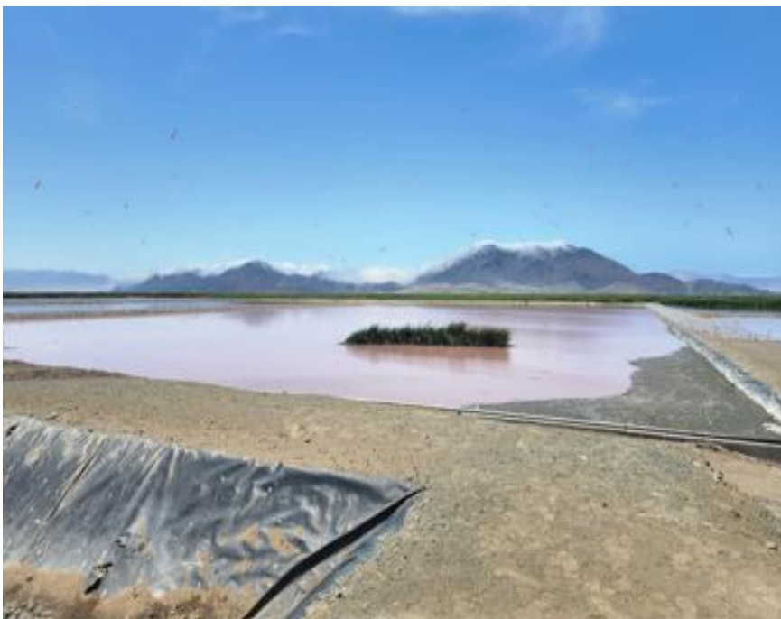
Gráfico 12: PTAR Las Gaviotas – Lagunas de Oxidación Zona Las Gaviotas frente a la Bahía de Chimbote – Nuevo Chimbote
