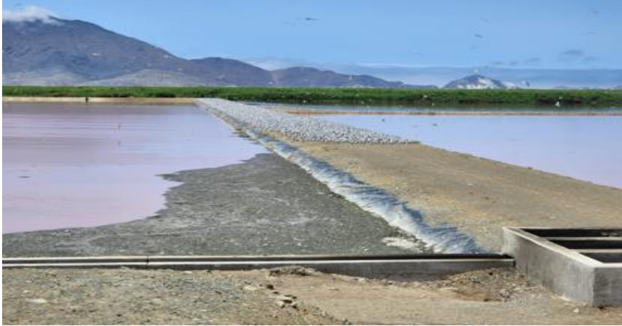
Gráfico 13: PTAR Las Gaviotas – Lagunas de Oxidación próximos a los Humedales
