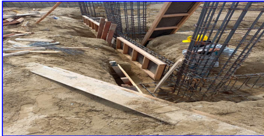
FIGURA N°19. Encofrado de vigas de cimentación.
