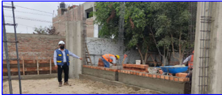
FIGURA N°37. Muro de Ladrillo KK Arcilla 18 Huecos – CABEZA.
