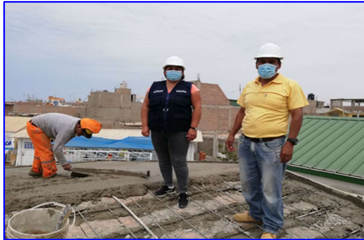
FIGURA N°31. Concreto en losa aligerada f'c=210 kg/cm 2 , colegio 1630.
