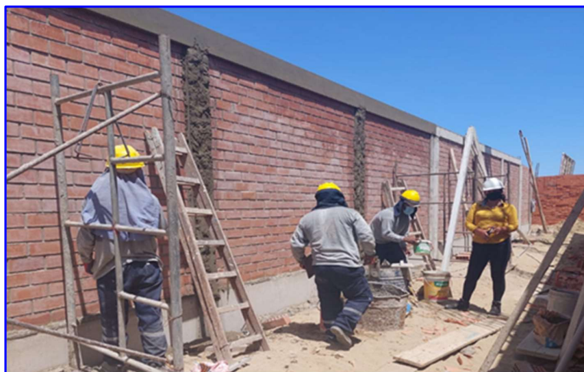
FIGURA N°42. Tarrajeo de vigas y columnas, e=1.5 cm, 1:5. en Colegio 1586.
