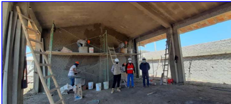
FIGURA N°39. Tarrajeo en Muro Interior e= 1.5 \text{ cm} , 1:5. Colegio 525.
