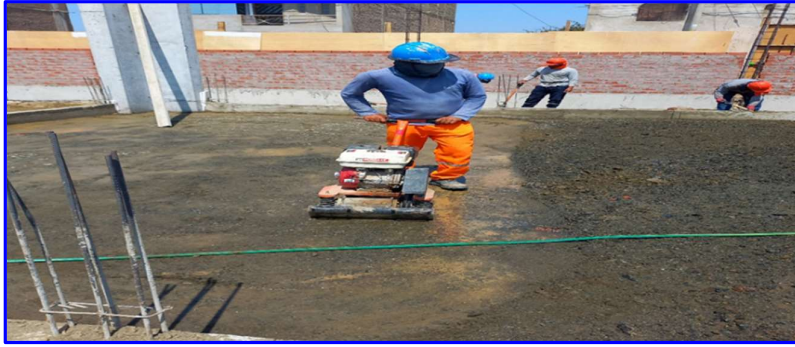
FIGURA N°7. Vista panorámica de trabajos en nivelación interior con afirmado compactado e=4'' , para el Colegio 517.
