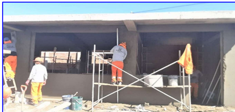
FIGURA N°41. Tarrajeo de columnas y placas, e=1.5 cm, 1:5. Colegio 88417.
