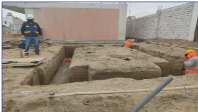
FIGURA N°3. Excavación manual de zapatas en Colegio 88393.
