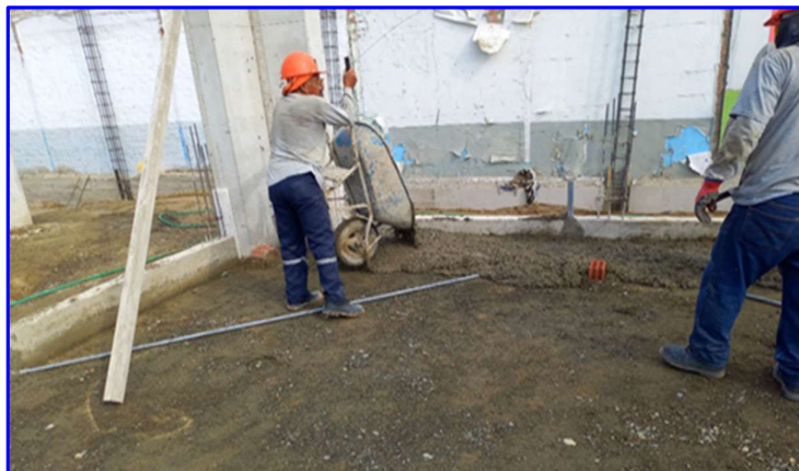
FIGURA N°12. Colocación de concreto para falso piso de 4" de concreto.
