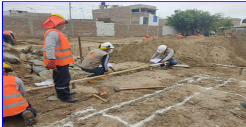
FIGURA N°1. Excavación manual de zapatas en Colegio 525.
