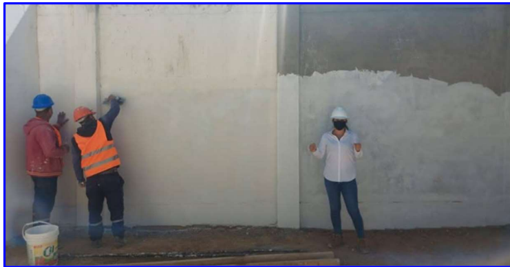
FIGURA N°47. Pintura látex en muros interiores, exteriores y columnas.
