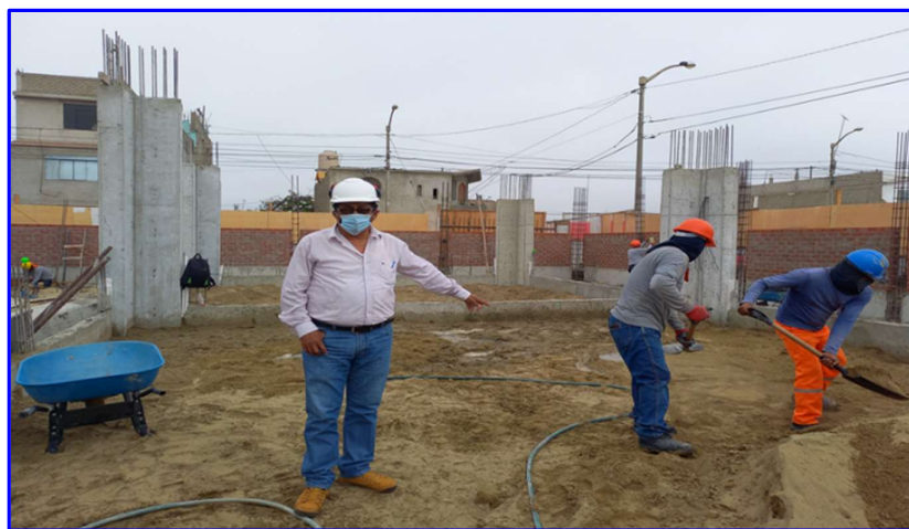
FIGURA N°6. Nivelación interior con afirmado compactado e=4'' , para el Colegio 88389.
