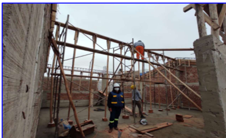
FIGURA N°27. Encofrado de losa aligerada y vigas en el Colegio 88393.
