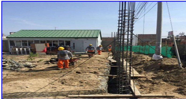
FIGURA N°17. Colocación de concreto en zapatas f'c=210 kg/cm 2 .
