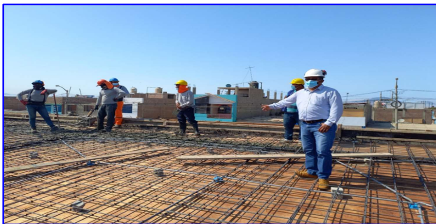
FIGURA N°33. Concreto en losa aligerada f'c=210 kg/cm 2 , Colegio 88389.
