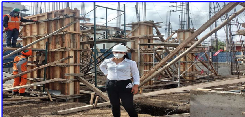
FIGURA N°26. Encofrado en Placas.
