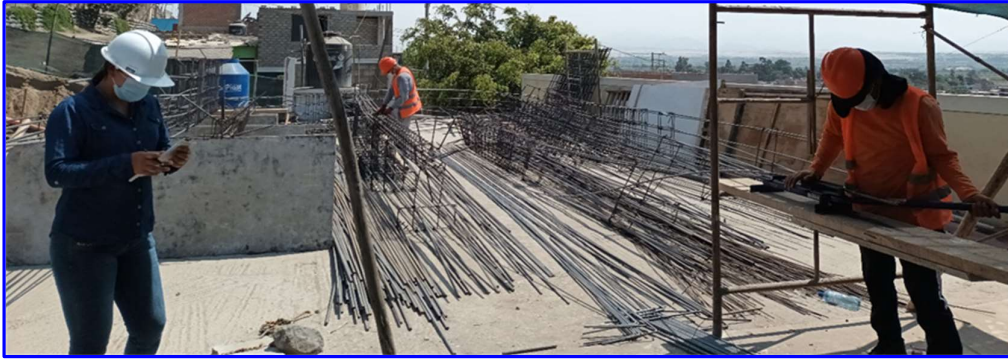
FIGURA N°28. Acero corrugado F_y = 4200 \text{ kg/cm}^2 grado 60 para vigas.
