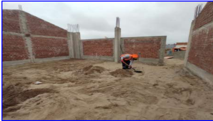
FIGURA N°4. Relleno con material propio manual en el Colegio 315.
