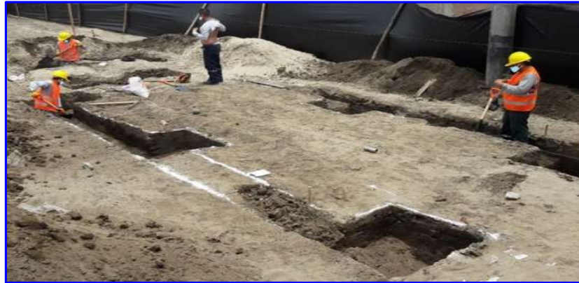
FIGURA N°1. Excavación manual de zapatas en Colegio 525.
