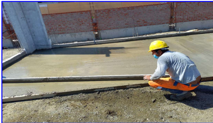
FIGURA N°11. Regleado de concreto en Falso piso de 4" de concreto.
