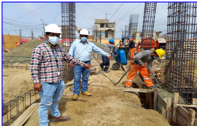
FIGURA N°15. Concreto en zapatas f'c=210 kg/cm 2 , I.E. 88389.
