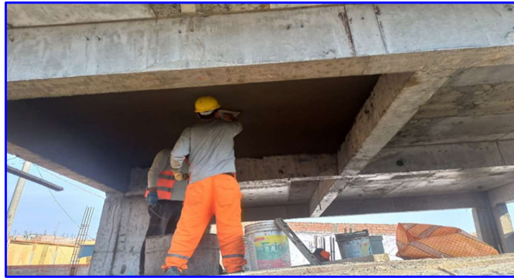
FIGURA N°46. Tarrajeo en Cielo raso con mezcla 1:4. Colegio 88204.
