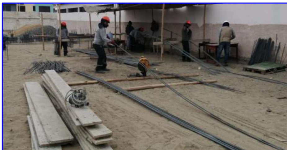
FIGURA N°18. Habilitación de Acero corrugado F_y= 4200 kg/cm 2 grado 60.
