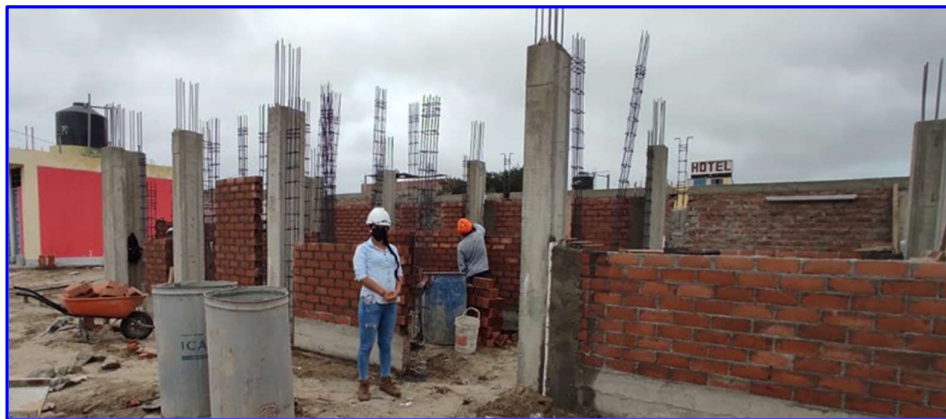
FIGURA N°38. Muro de Ladrillo KK Arcilla 18 Huecos – CABEZA, Colegio 88393.
