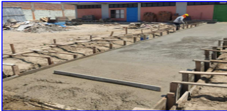
FIGURA N°14. Concreto en veredas f'c=175 kg/cm 2 .
