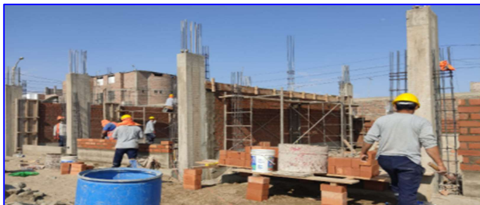
FIGURA N°36. Muro de Ladrillo KK Arcillo 18 HUECOS – SOGA, Colegio 1630.
