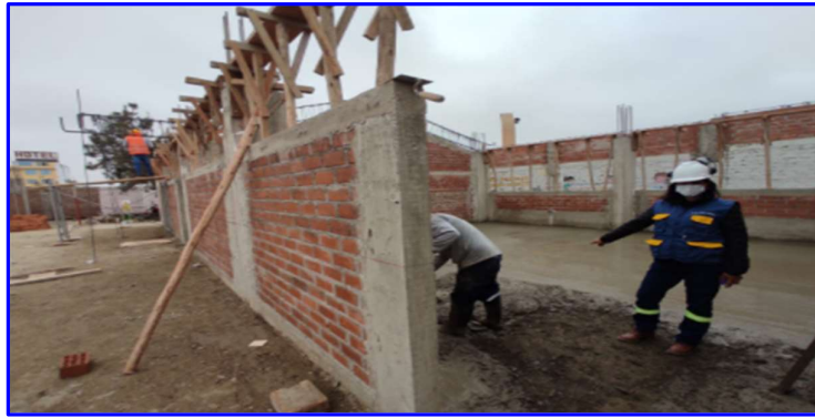
FIGURA N°13. Falso piso de 4" de concreto en el Colegio 88393.
