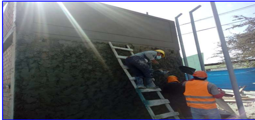
FIGURA N°40. Tarrajeo en muro interior e= 1.5 cm, 1:5. Colegio 315.
