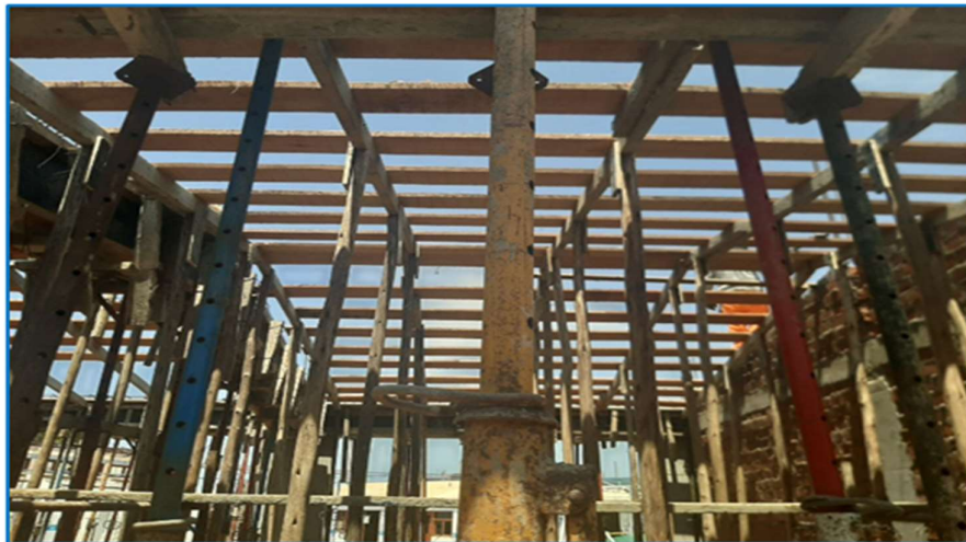
FIGURA N°30. Encofrado y desencofrado en losa aligerada, Colegio 1630.
