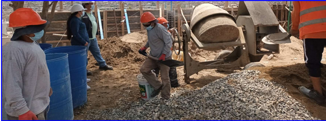
FIGURA N°25. Preparación de Concreto para Placas f'c=210 kg/cm 2 .
