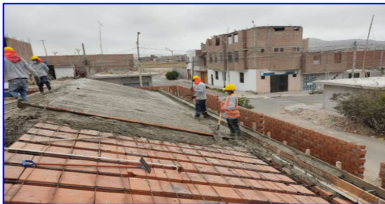
FIGURA N°31. Concreto en losa aligerada f'c=210 kg/cm 2 , colegio 1630.
