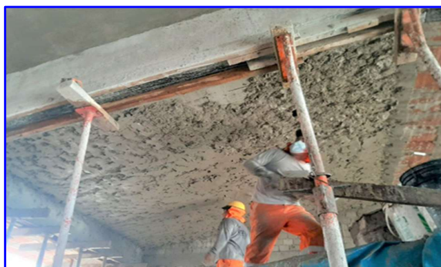
FIGURA N°45. Tarrajeo en Cielo Raso con mezcla 1:4. Colegio 88389.
