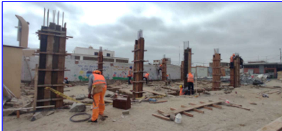
FIGURA N°23. Encofrado de en columnas, colegio 88393.
