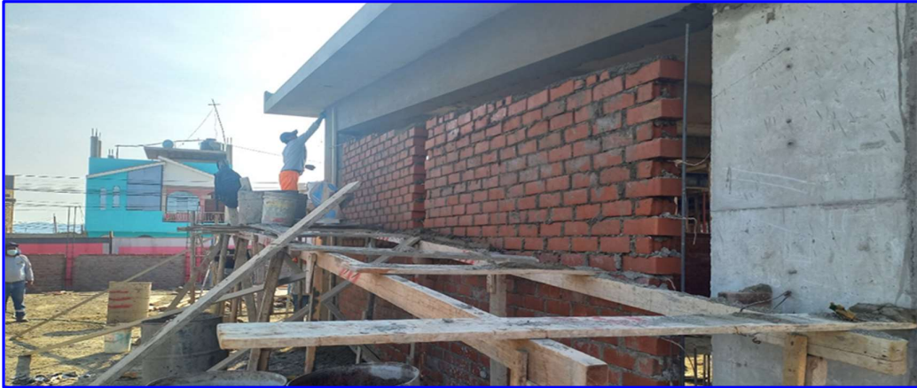
FIGURA N°43. Tarrajeo de vigas, e=1.5\text{cm} , 1:5. en Colegio 88417.
