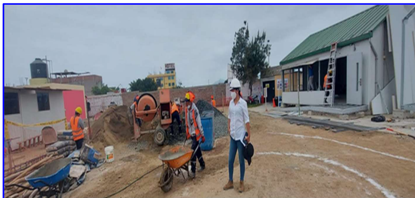
FIGURA N°9. Elaboración de concreto para sobrecimientos mezcla 1:8 + 25% P.M.
