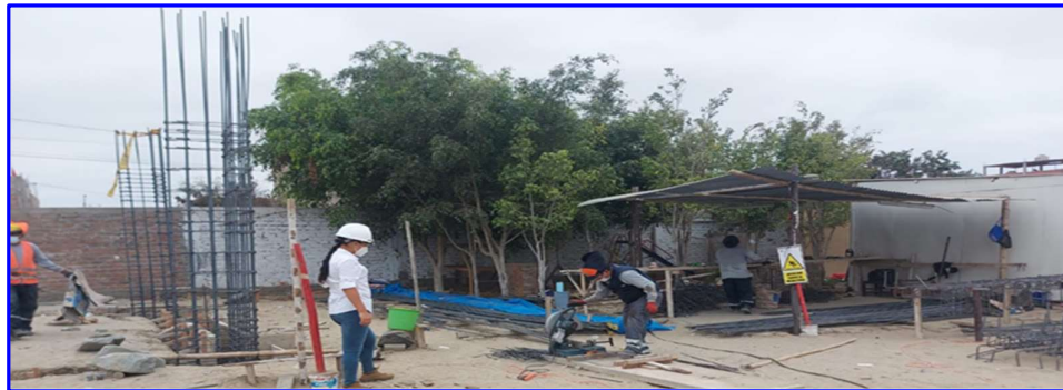
FIGURA N°24. Acero corrugado F_y = 4200 \text{ kg/cm}^2 grado 60 para columnas.
