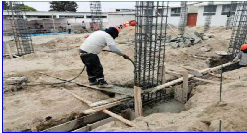
FIGURA N°16. Vaciado de concreto en zapatas f'c=210 kg/cm 2 .
