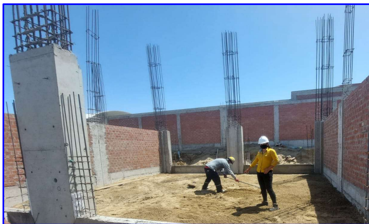
FIGURA N°4. Relleno con material propio manual en el Colegio 315.
