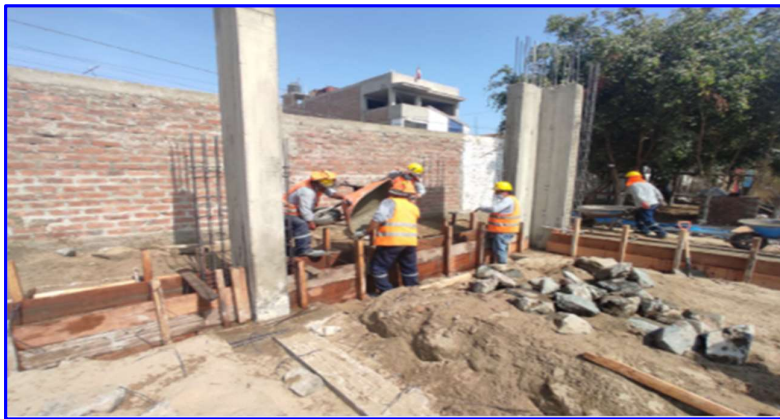
FIGURA N°8. Concreto Ciclopeo para cimientos corridos 1:10 + 30% P.G
