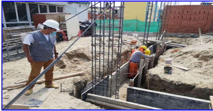
FIGURA N°10. Encofrado de sobrecimientos. I. E. 1630.
