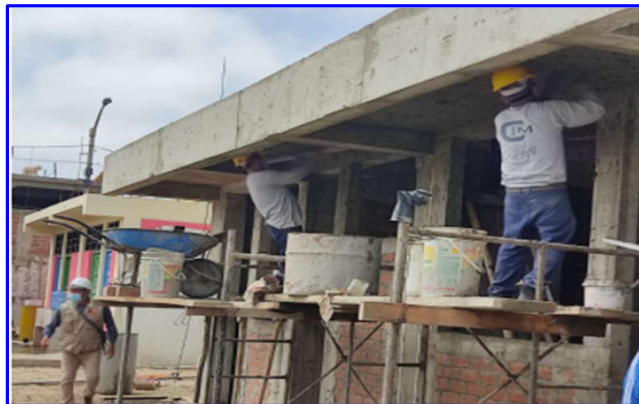
FIGURA N°44. Tarrajeo en Cielo Raso con mezcla 1:4. Colegio 525.
