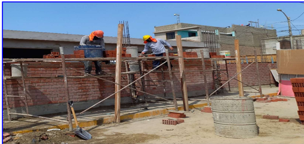
FIGURA N°35. Muro de Ladrillo KK Arcillo 18 Huecos – SOGA Colegio 88024.
