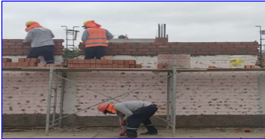
FIGURA N°34. Muro de Ladrillo KK Arcillo 18 HUECOS – SOGA Colegio 88389.
