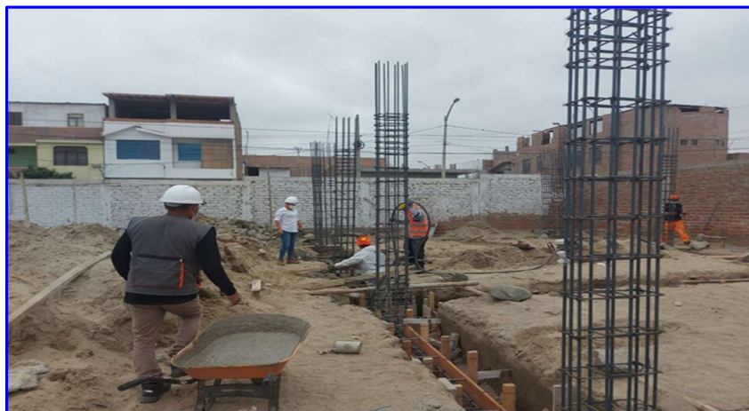
FIGURA N°20. Concreto en vigas de cimentación f'c=210 kg/cm.
