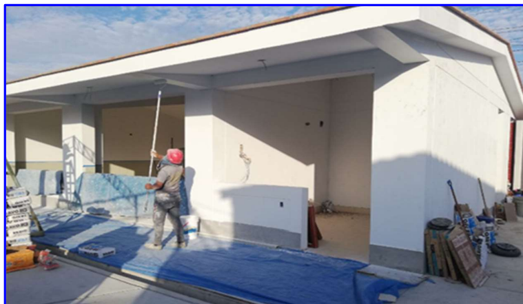
FIGURA N°48. Trabajos de Pintura látex en Vigas y Cielo Rasos.
