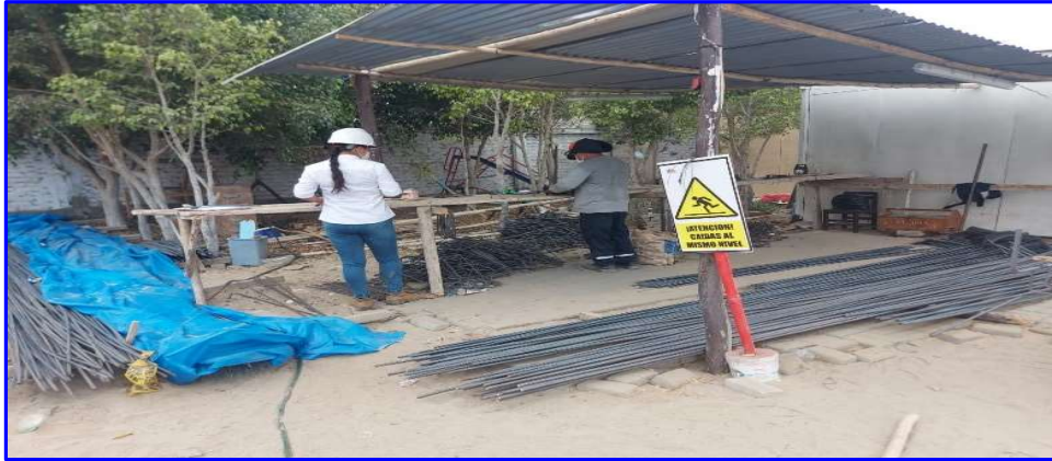
FIGURA N°22. Habilitación de acero corrugado F_y = 4200 \text{ kg/cm}^2 grado 60, para vigas de cimentación
