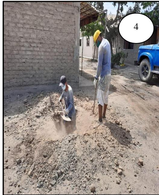
FOTOGRAFÍA N° 1, 2, 3 y 4: Excavación y extracción de muestras C1, C2, C3 y C4
