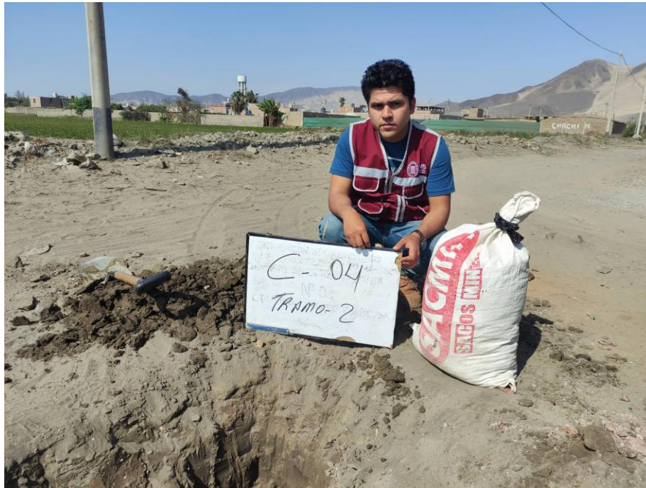
Fotografía N°3. Excavación y toma de muestra de la calicata C-04 en una vía de acceso.
