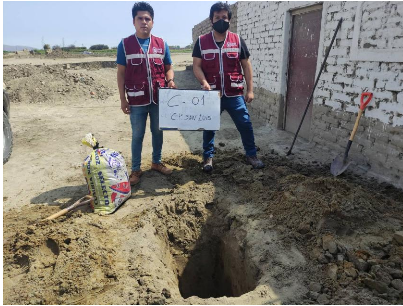
Fotografía N°1. Excavación y toma de muestra de calicata C-01 en centro poblado San Luis
