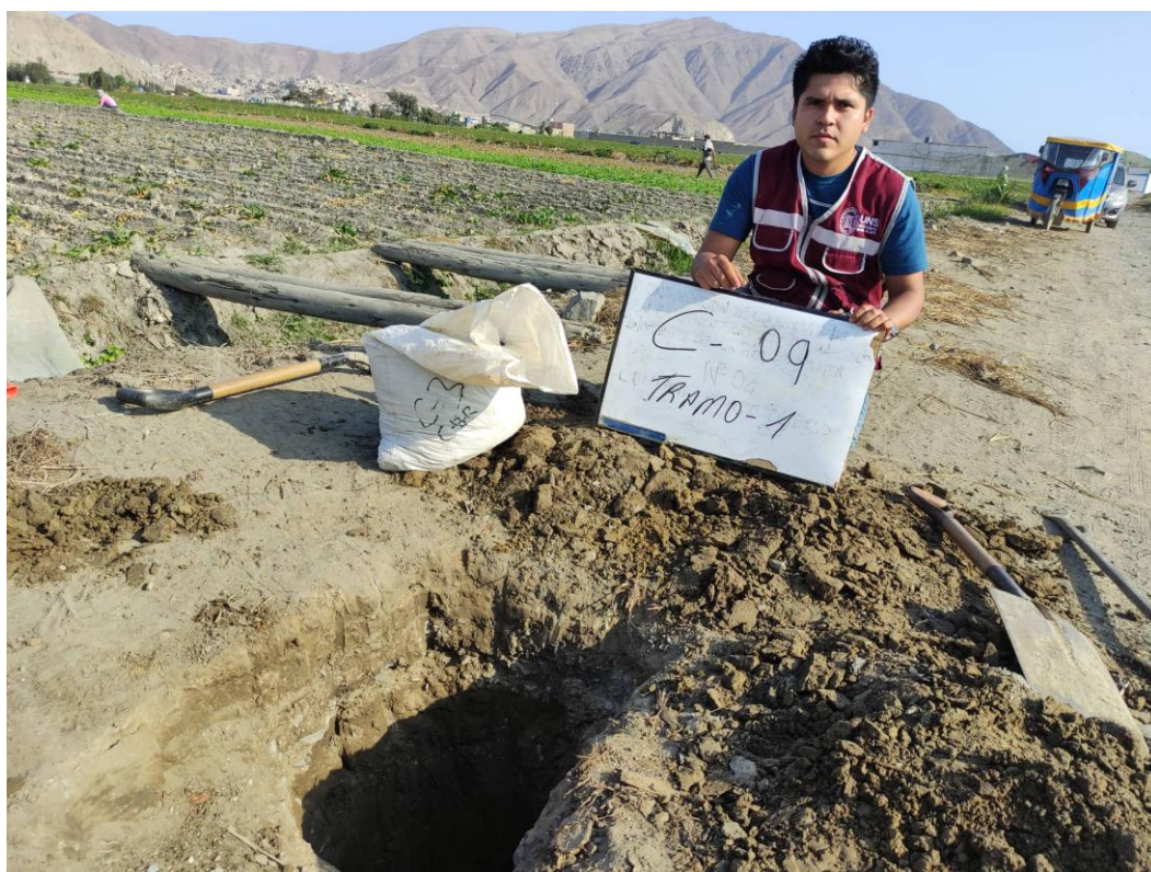
Fotografía N°8. Excavación y selección de muestra de la calicata #9 en una vía de acceso.
