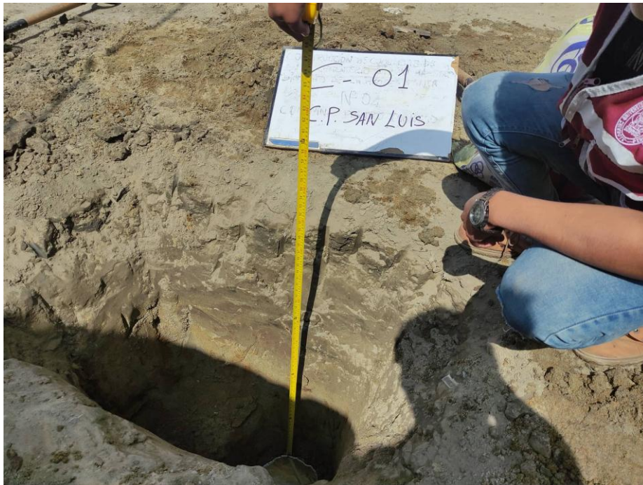
Fotografía N°2. Medición de la profundidad alcanzada debido al nivel freático.
