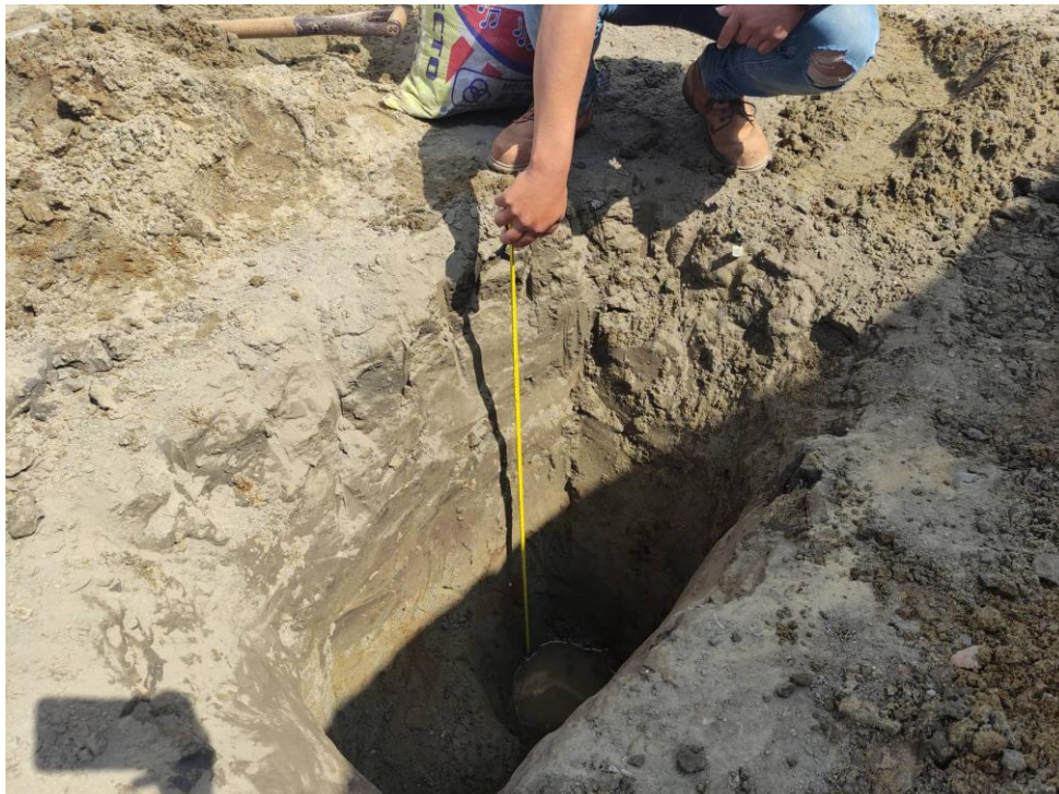
Fotografía N°4. Medición de la profundidad alcanzada debido al nivel freático.
