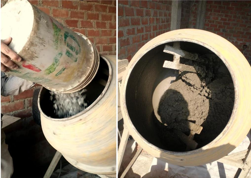
*Figura 64: Mezclado mecánico de los materiales empleando mezcladora tipo trompo*
