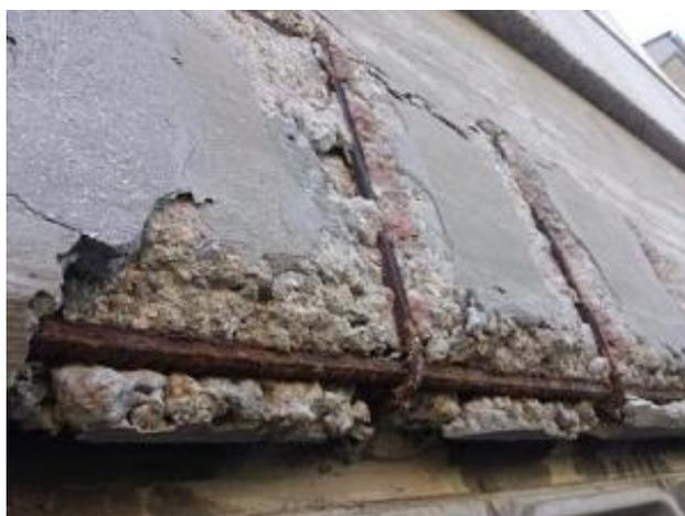
*Figura 6: Corrosión de armadura por filtración*
