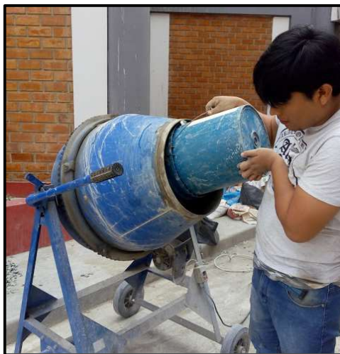
(c) Agregado de los materiales en el trompo
