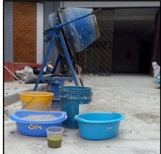
(b) Dosificación de los agregados
