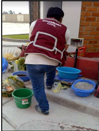
(a) Pesaje de los materiales para el concreto
