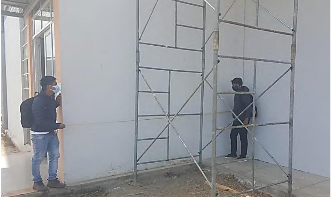
Fotografía A-7. Toma de medidas de Placa P-1 que forma parte de la estructura del bloque A y bloque E.
