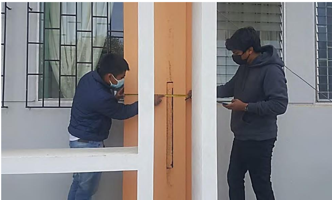
Fotografía A-3. Medición de columnas C3 en la zona donde colindan el Bloque A y Bloque B. Se observa la junta sísmica entre ambos bloques.
