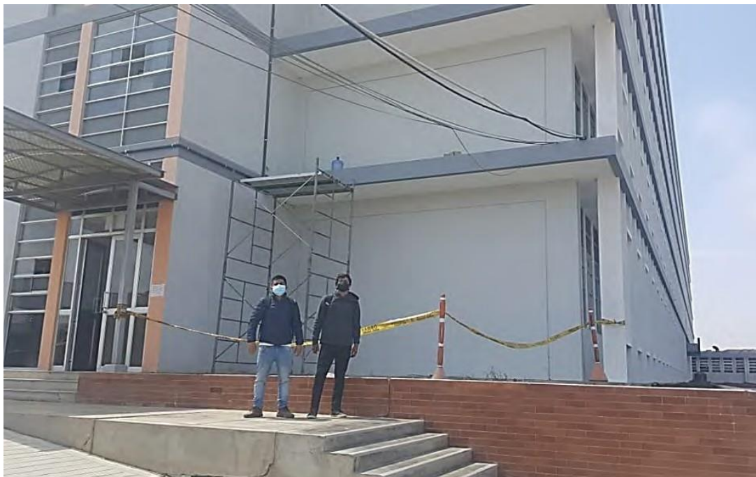
Fotografía A-6. Vista de la Elevación C de la estructura principal del Hospital Regional Eleazar Guzmán Barrón.
