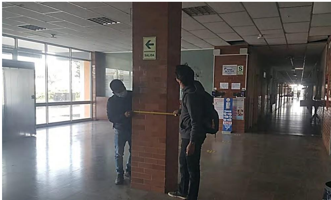
Fotografía A-14. Medición de columna tipo C5 que conforma la estructura del bloque C.
