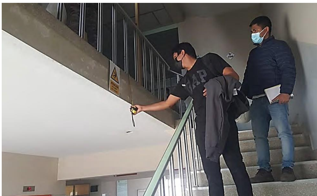
Fotografía A-24. Medición de espesor de losa de entepiso de la estructura principal del Hospital Regional Eleazar Guzmán Barrón.
