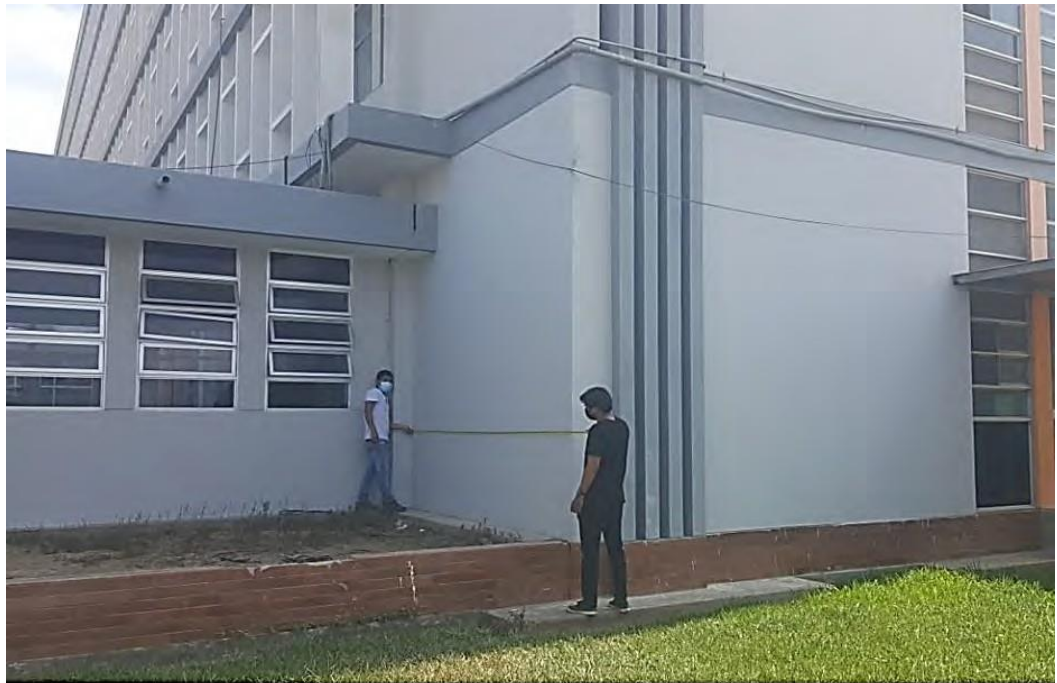
Fotografía A-18. Medición del largo de la placa P-1 que forma parte de la estructura de los bloques A y E.
