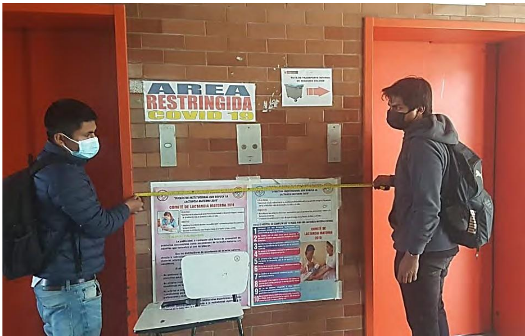
Fotografía A-12. Toma de medidas de las placas que conforman las cajas de ascensores ubicado en el bloque C.
