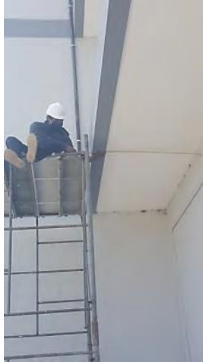
Fotografía A-9. Medición de Voladizo ubicado en los bloques A y E.
