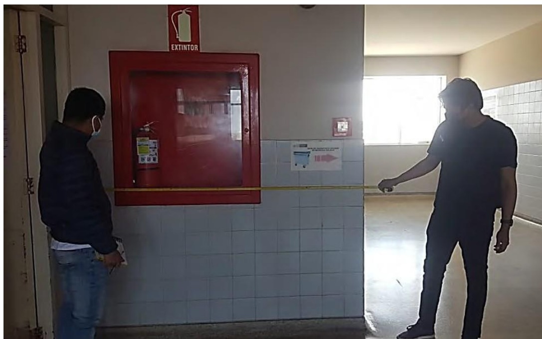
Fotografía A-23. Medición de Placa P-3 que forma parte de la estructura del bloque C.
