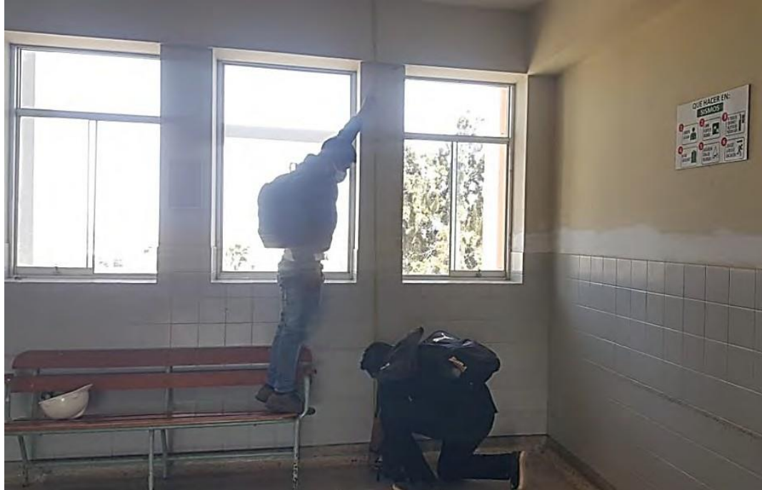
Fotografía A-19. Medición de altura de entpiso de la estructura principal del Hospital Regional Eleazar Guzmán Barrón. Cabe indicar que se tiene una misma altura de entpiso para los niveles 2, 3, 4 y 5.
