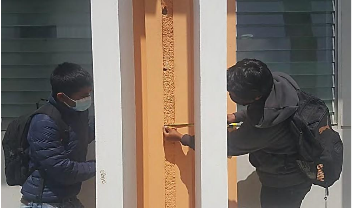
Fotografía A-11. Medición de Junta sísmica entre los bloques D y E.
