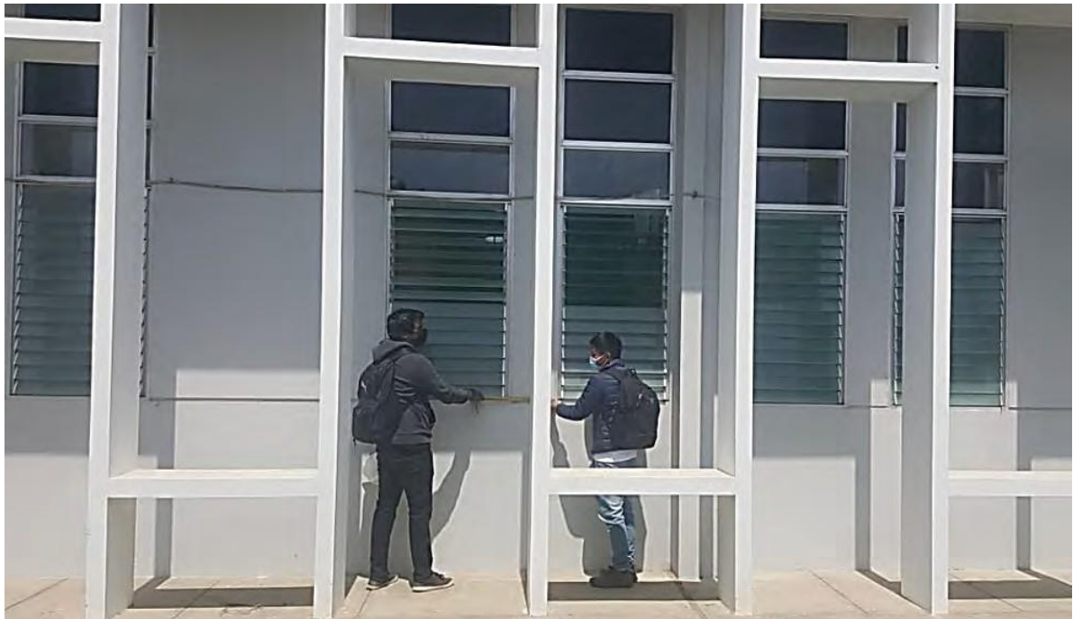
Fotografía A-10. Mediciones de columnetas y muretes en el perímetro del bloque B y bloque D.
