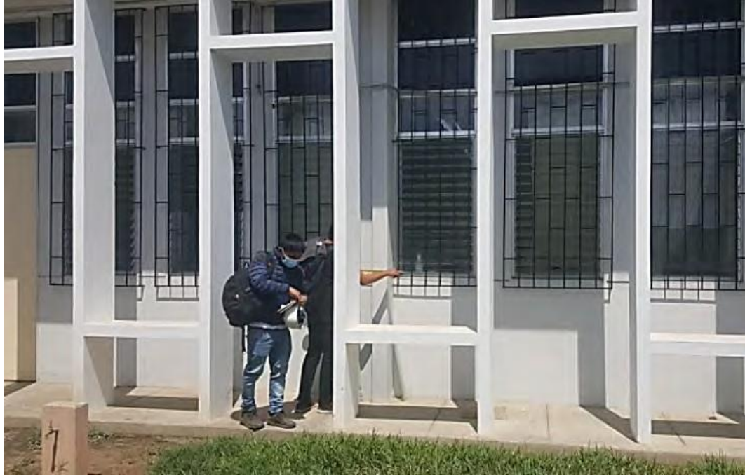
Fotografía A-27. Toma de medición de la sección de la columna tipo C2 en el bloque D.
