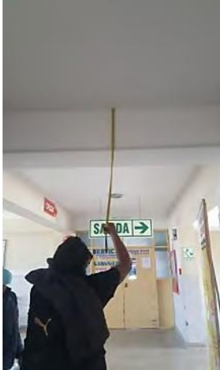
Fotografía A-20. Medición de peraltes de viga VT-11 que forman parte de la estructura de los bloques A, B, C, D y E.
