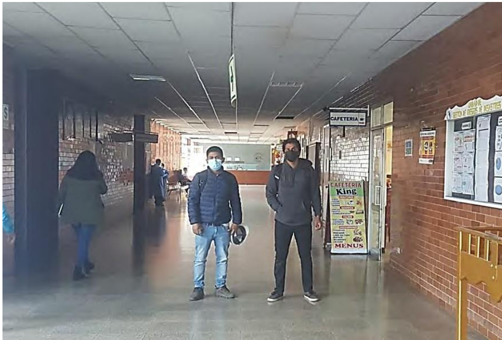
Fotografía A-16. Vista Interior de la estructura del bloque D.
