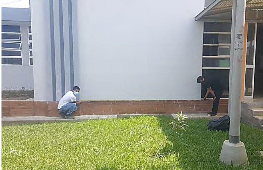
Fotografía A-17. Medición del largo de la placa P-2 que forma parte de la estructura de los bloques A y E.
