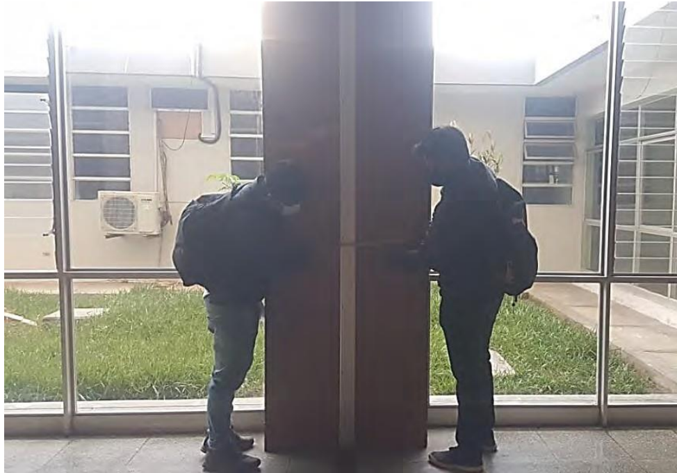
Fotografía A-15. Toma de medidas de la junta sísmica y columnas tipo C3 en la zona donde colindan los bloques D y E.
