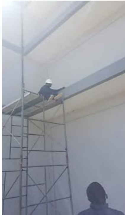
Fotografía A-8. Medición de espesor de losa del primer piso de la estructura principal del Hospital Regional Eleazar Guzmán Barrón.
