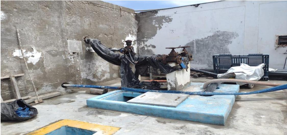
Foto 10: Bomba de emisario submarino completamente obsoleto en el DPA.
