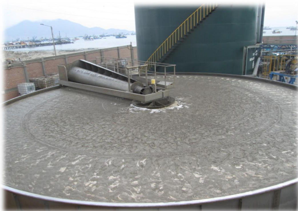
Gráfico 7. Tanque Clarificador, marca ST MACHINE - 200 m 3
