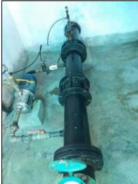
Pozo N° 5: Tubería de impulsión, bomba para mezclar el cloro gaseoso con el agua de la tubería de impulsión, válvula mariposa de cierre.
