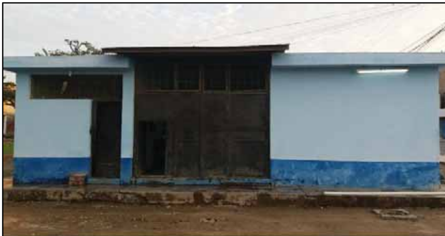
Pozo N° 7: Caseta de bombeo del pozo, ubicada dentro de un parque en zona urbana.
