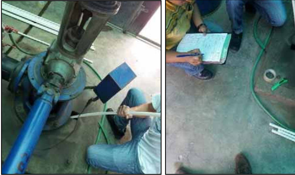
Pozo N° 7: Instalación de tubo PVC-U 19.1 mm (3/4”) L (SEL) para medir el nivel freático; lectura del nivel freático
