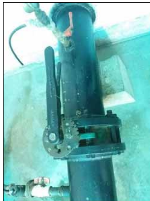
Pozo N° 5: Tubería de impulsión, bomba para mezclar el cloro gaseoso con el agua de la tubería de impulsión, válvula mariposa de cierre.
