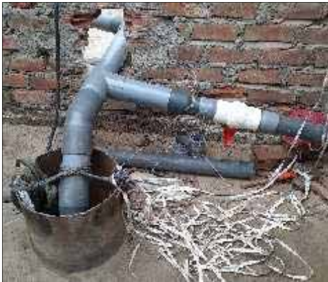
Pozo B1: Extracción de agua subterránea para fines de riego a 15 l/s, con una bomba sumergible; motor mecánico con funcionamiento a Gas.
