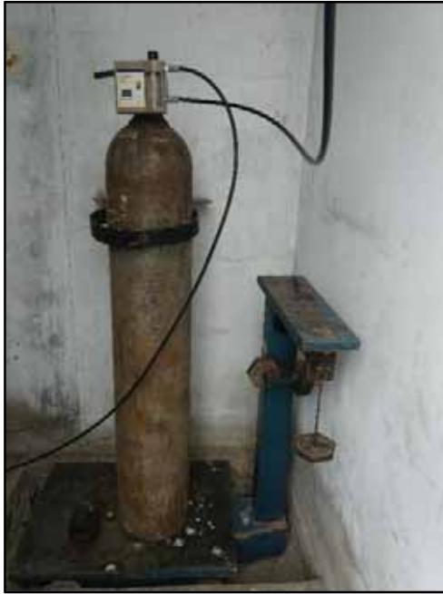
Pozo N° 5: Regulador de cloro, balón de cloro, balanza, bomba para mezclar el gas de cloro con el agua extraída.
