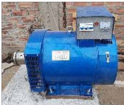
Pozo B1: Generador eléctrico; Tablero de control de energía eléctrica.
