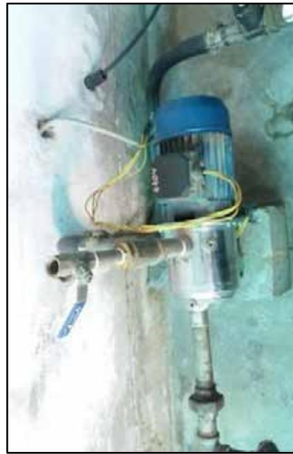
Pozo N° 5: Regulador de cloro, balón de cloro, balanza, bomba para mezclar el gas de cloro con el agua extraída.
