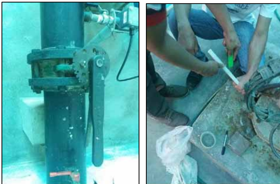
Pozo N° 6: válvula mariposa de cierre en la tubería de impulsión; colocación de los tubos PVC-U 19.1 mm (3/4”) L (SEL) para medir el nivel freático.
