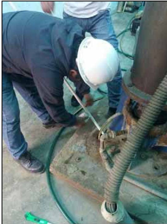
Pozo N° 5: DPD Sulfato para identificar el cloro residual; colocación de los tubos PVC-U 19.1 mm (3/4") L (SEL) para medir el nivel freático.
