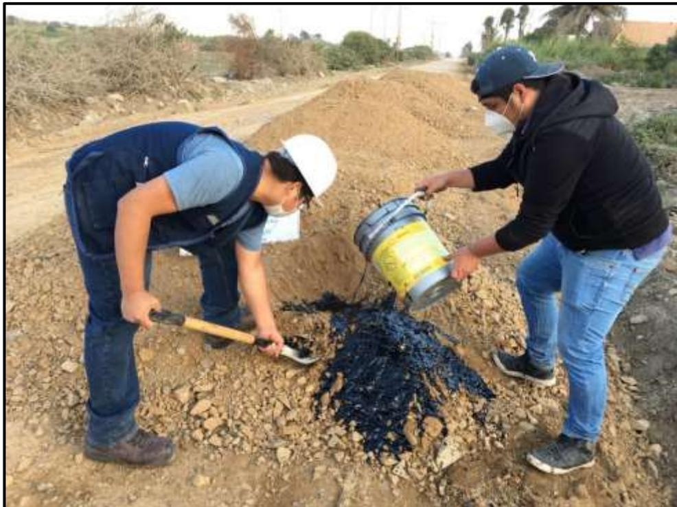
**Fotografía 24. Preparación de Afirmado con Residuo de Lubricante Vehicular**
