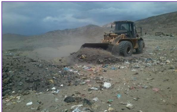
*Foto n° 05: Rectificación de taludes para los residuos sólidos.*
